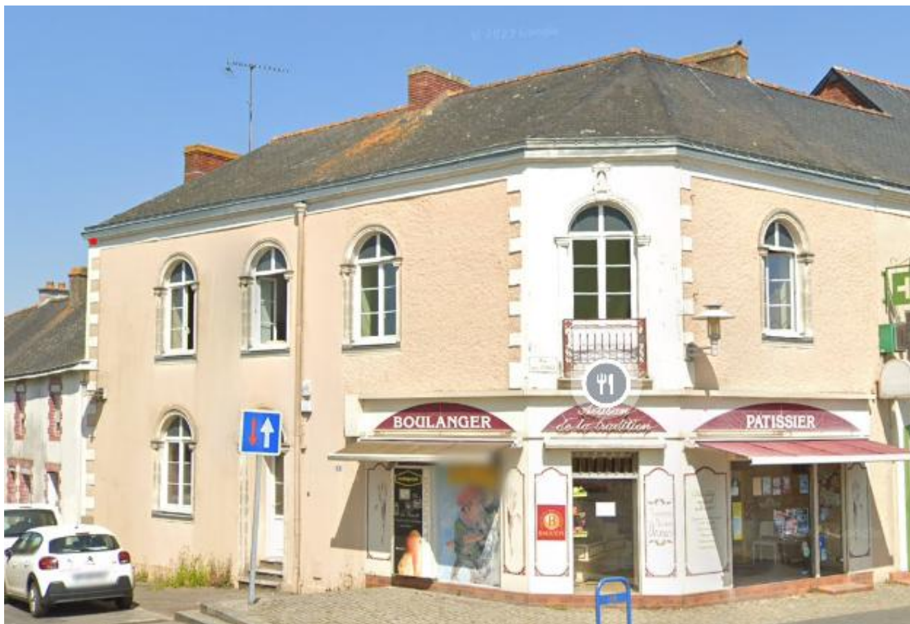
(Photo prise avant le démontage de la façade bois)
