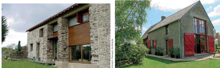
Transformation d'une grange en habitation au Loroux-Bottereau. ©Vincent Perraud.
