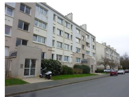
Les immeubles réhabilités du quartier Saint-Laurent à Blain
