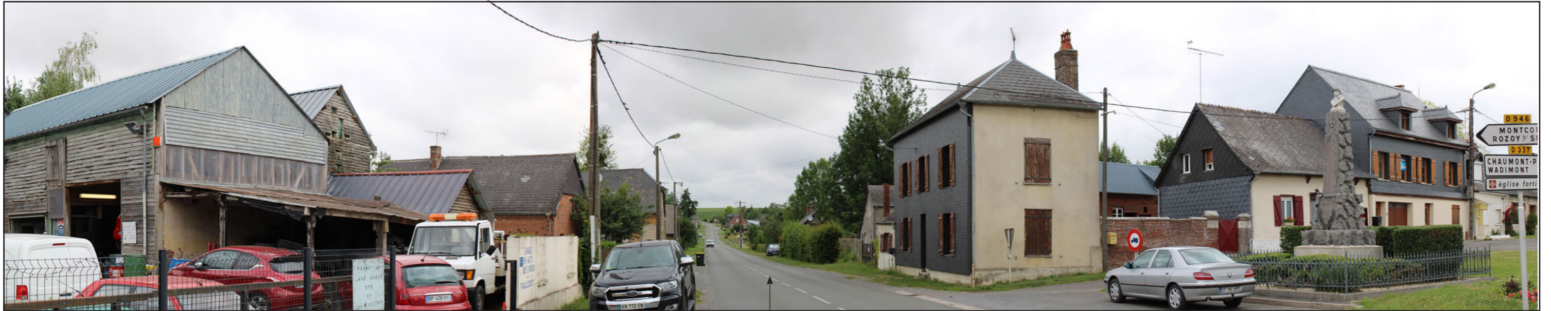
État initial - Vue panoramique 120 °
