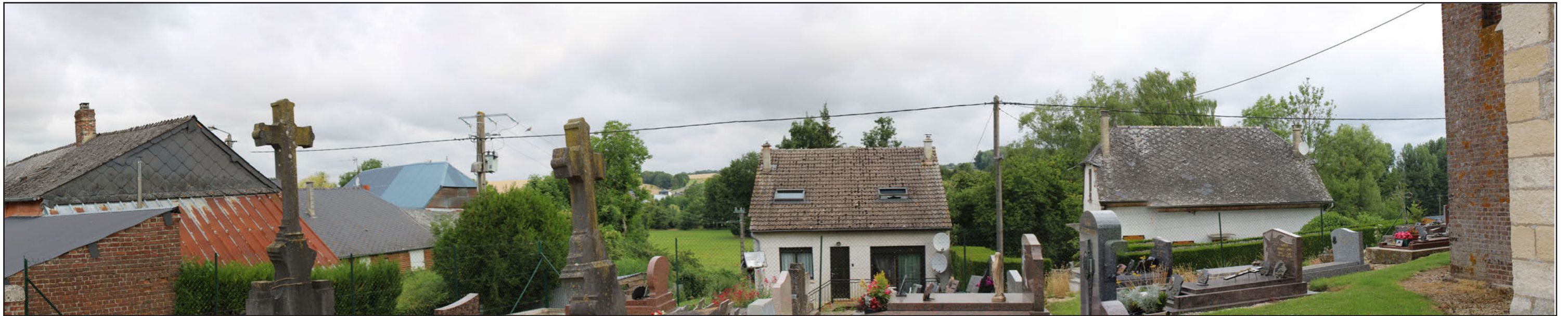
État initial - Vue panoramique 120 °
