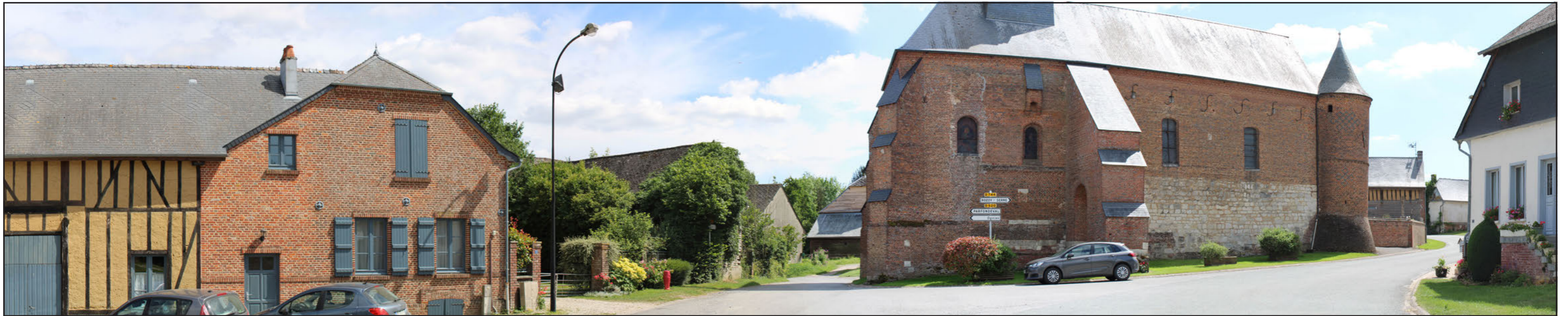
État initial - Vue panoramique 120 °
