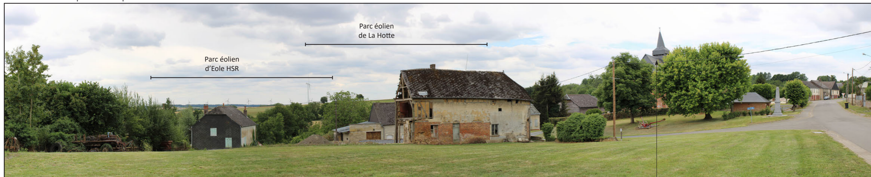
État initial - Vue panoramique 120 °
