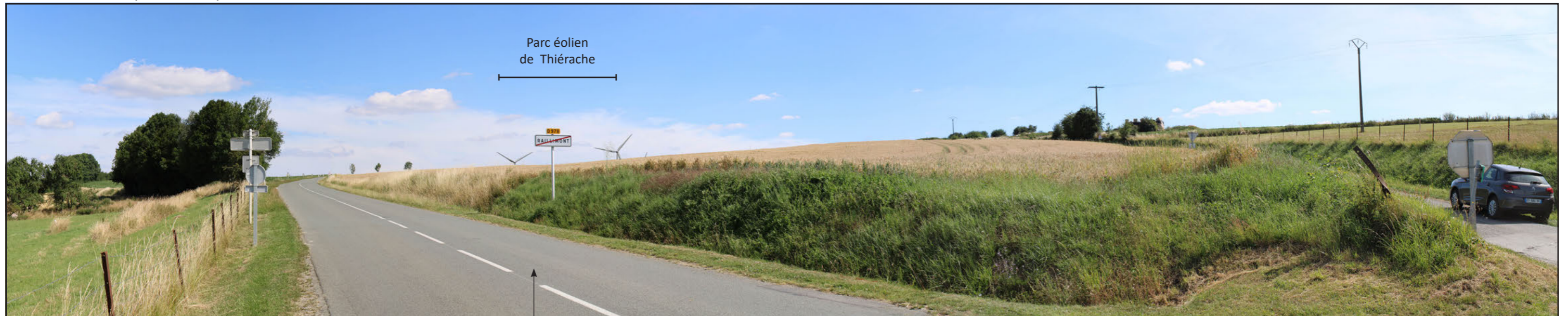
État initial - Vue panoramique 120 °
