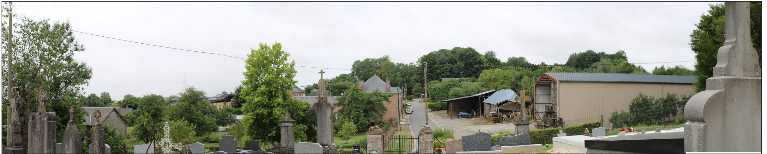
État initial - Vue panoramique 120 °
