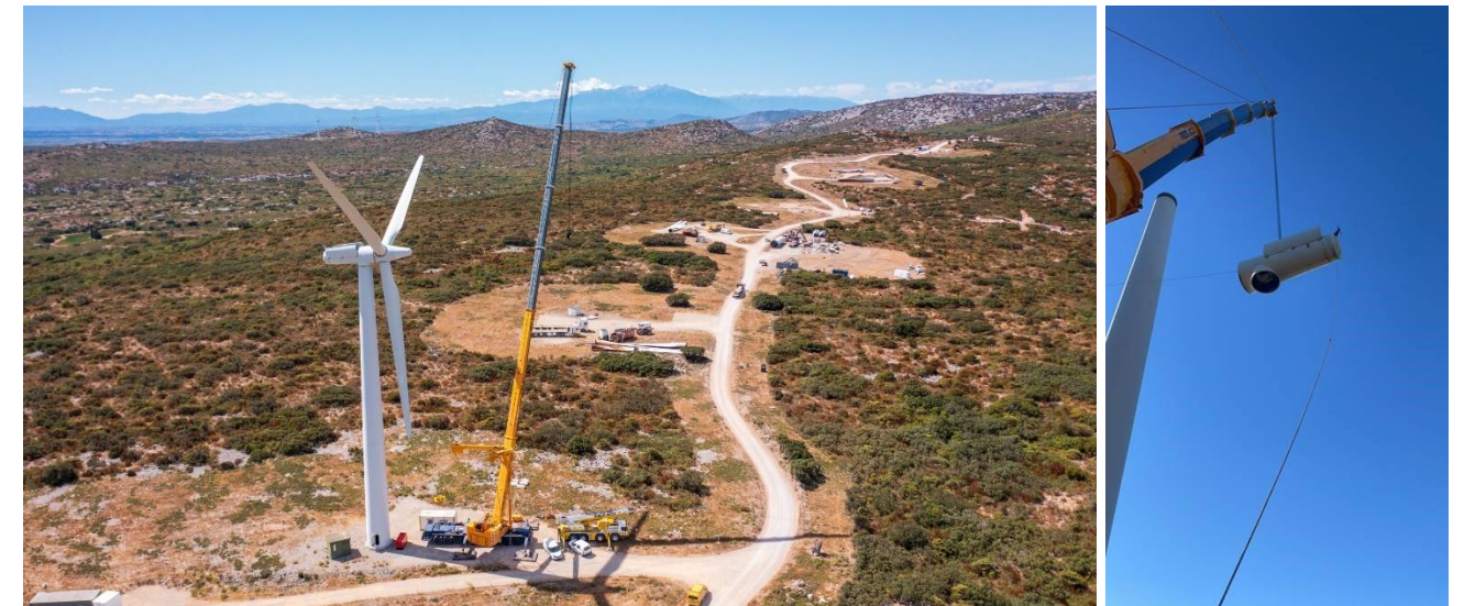
Démantèlement d'un parc éolien Source : Q ENERGY France
