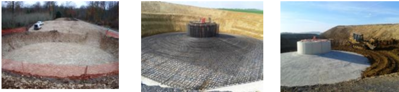
Réalisation des fondations ; phase d'excavation ; phase de ferrailage ; phase de remblaiement Source : Q ENERGY France
