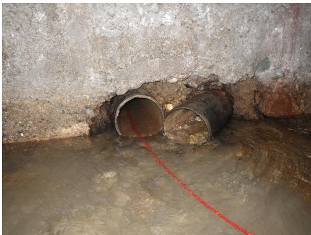
Captage Sud du Bois d'Anthy. Arrivée des drains n° 4 et 5.
