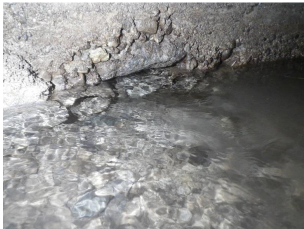
Captage Sud du Bois d'Anthy. Arrivée des drains n°1 et 2
