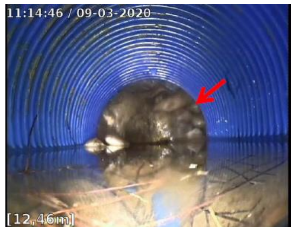
Illustration. Extrémité du drain dans terrain naturel. Drain n°4.
