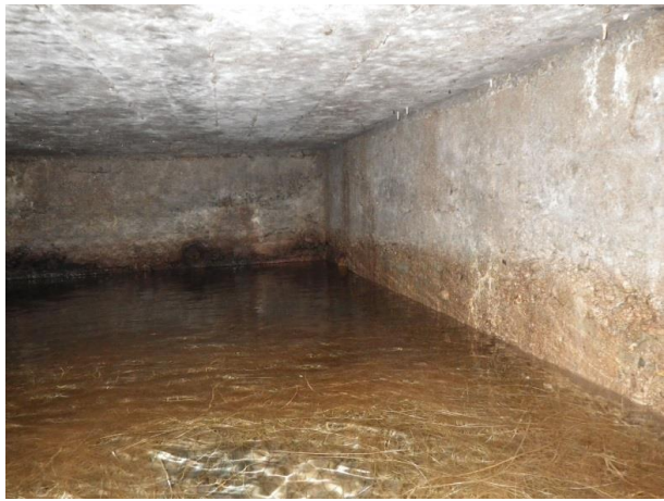
Captage Sud du Bois d'Anthy. Arrivée des drains n°7 et 8
