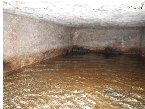
Captage Sud du Bois d'Anthy. Arrivée des drains n°6 et 7
