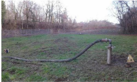
Installation – essai de pompage en cours
