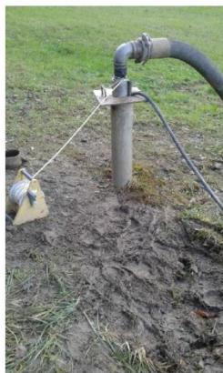
Tête de forage – essai de pompage en cours
