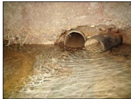
Des drains de 12m de long parviennent dans l'ouvrage.
