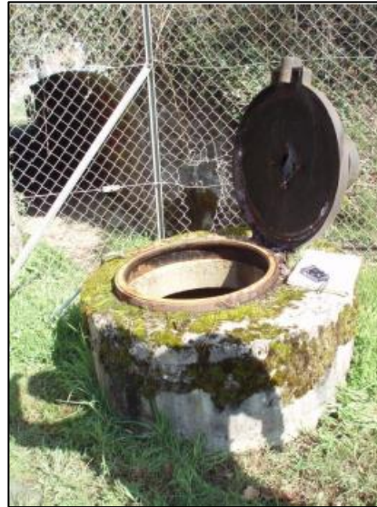
Vue extérieure du tampon Foug
