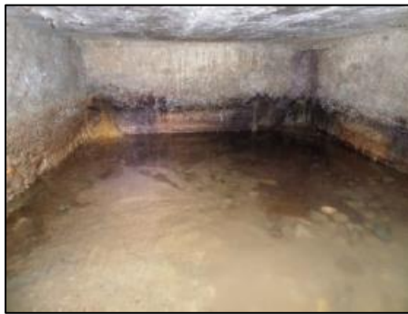
Chambre de captage de forme rectangulaire, de faible profondeur. Présence de drains et venues d'eau ascendantes.
