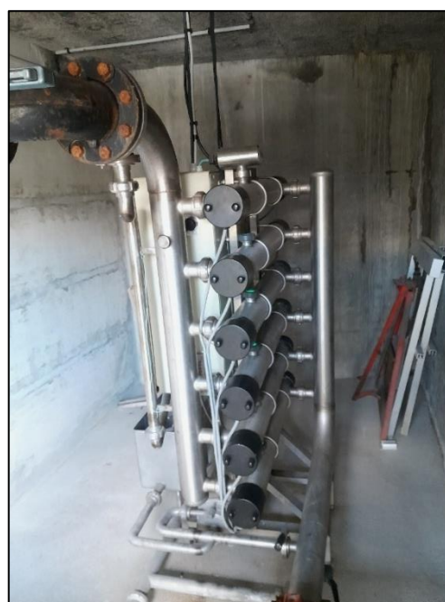
Figure 19 : Système UV de désinfection de l'eau - réservoir des Fourches (commune d'Anthy-sur-Léman)
