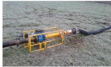
Compteur – essai de pompage en cours
