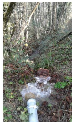
Point de rejet des eaux de pompage
