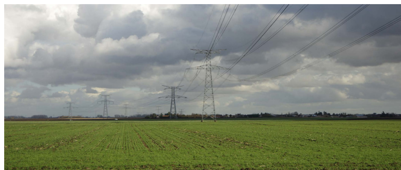
Silhouette de bourg concurrencée par les lignes Haute-Tension au sud de Pithiviers
