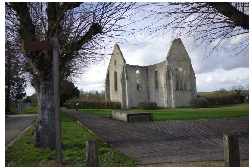
Abbaye et église à Yèvre-le-Châtel
