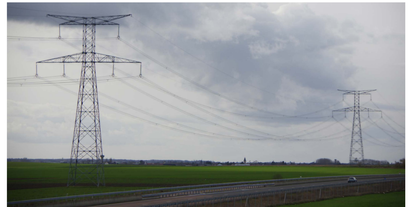
Monumentalité des lignes Haute-Tension dans un paysage très horizontal
