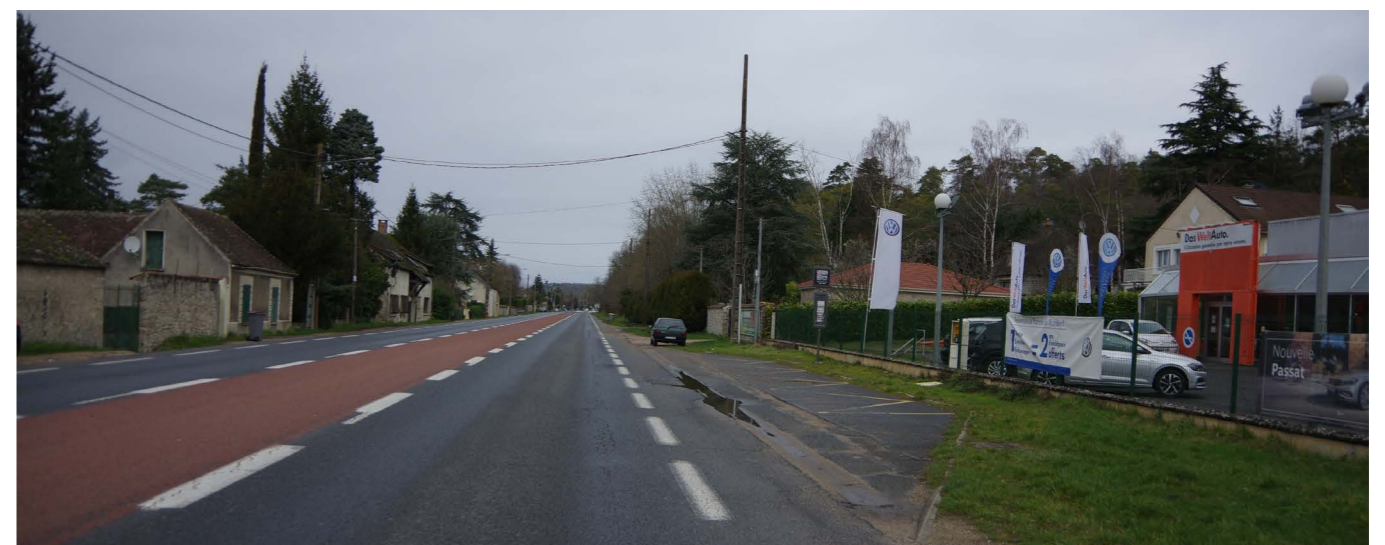
Abords urbanisés de la D2007 entre Souppes-sur-Loing et Bagneux-sur-Loing
