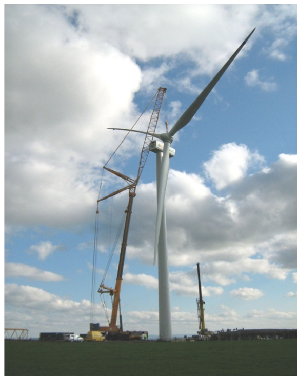
Photo 5 : Montage du rotor
