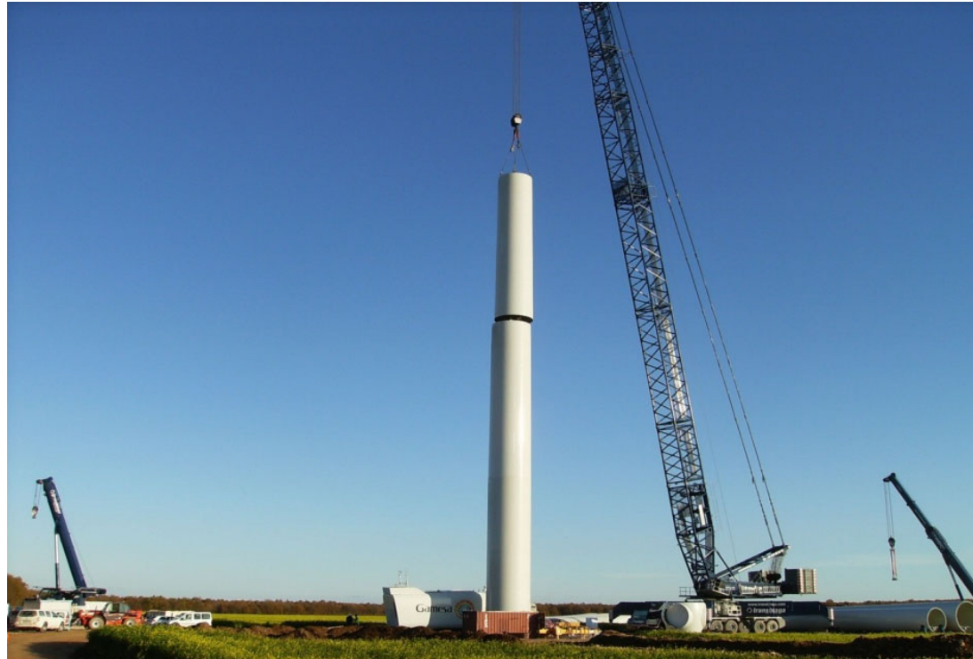
Photo 4 : Montage des éléments de la tour
