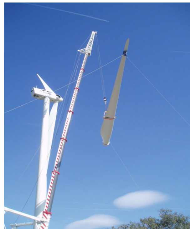
Photo 6 : Montage pale par pale
