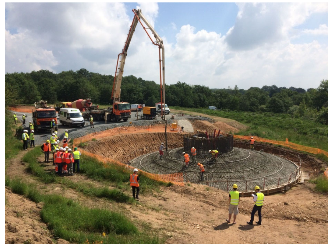
Photo 3 : Coulage du béton
