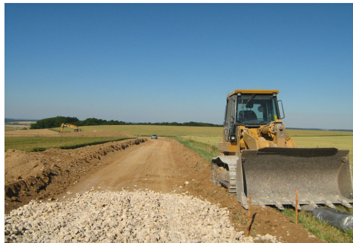
Photo 1 : Décapage du sol
