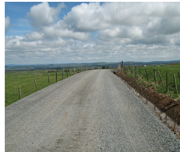
Photo 2 : Voie d'accès terminée
