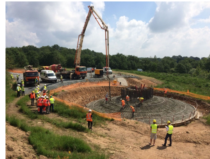
Photo 3 : Coulage du béton
