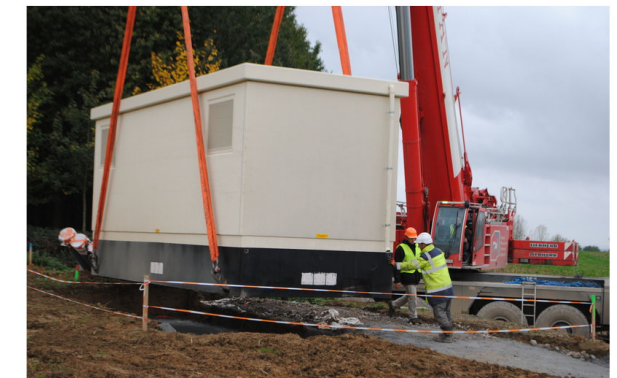
Photo 8 : Pose d'un poste de livraison
