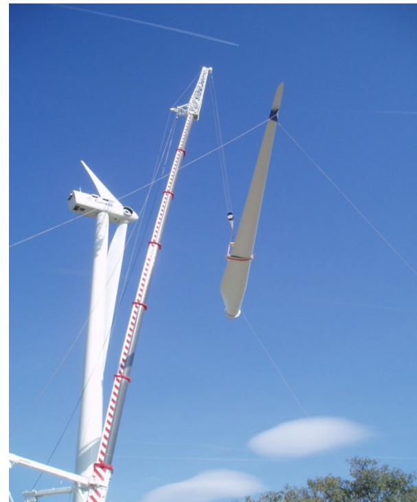
Photo 6 : Montage pale par pale
