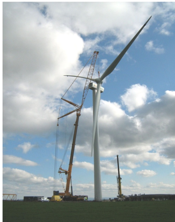
Photo 5 : Montage du rotor
