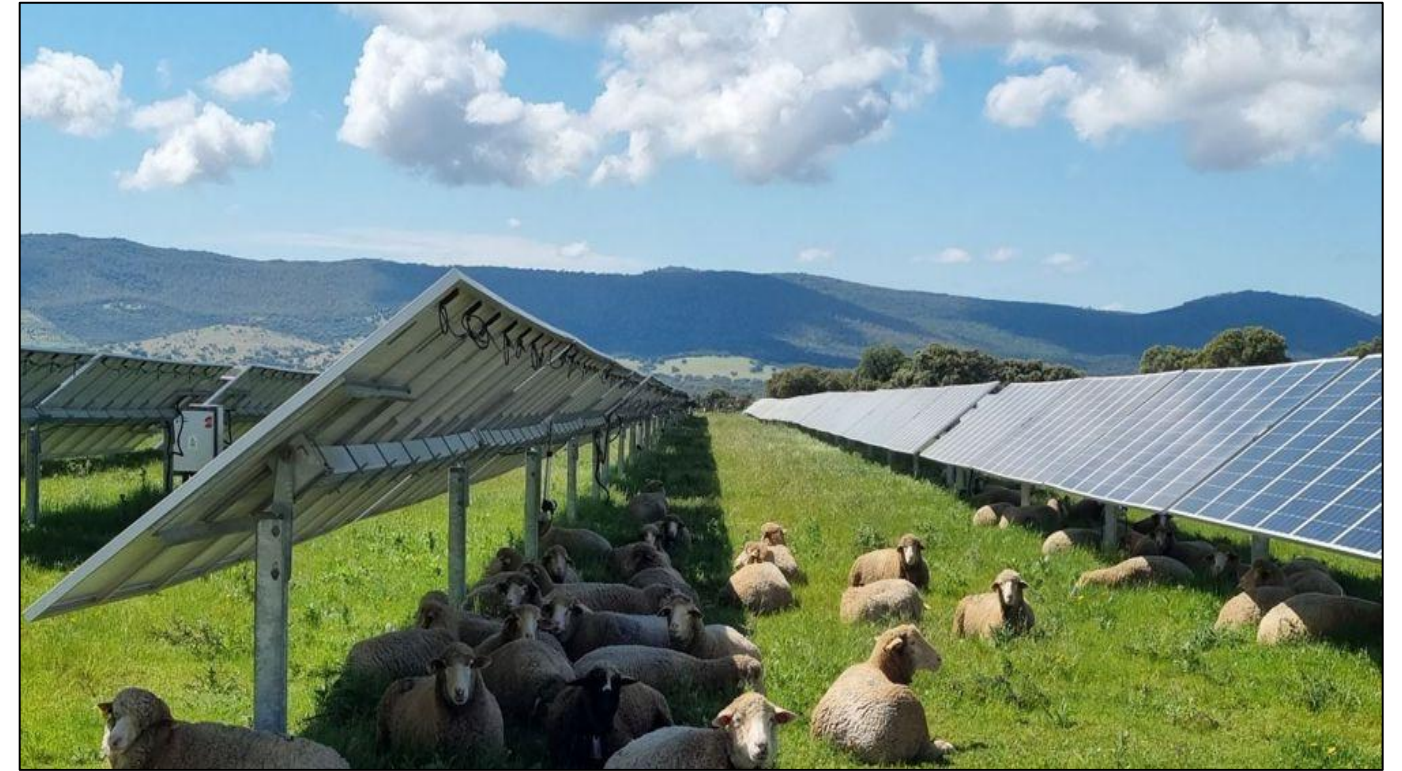
Photo 1 : Illustration d'un projet agrivoltaïque avec technologie trackers et ovins (Source : La France Agricole, projet ovin Enoé)
