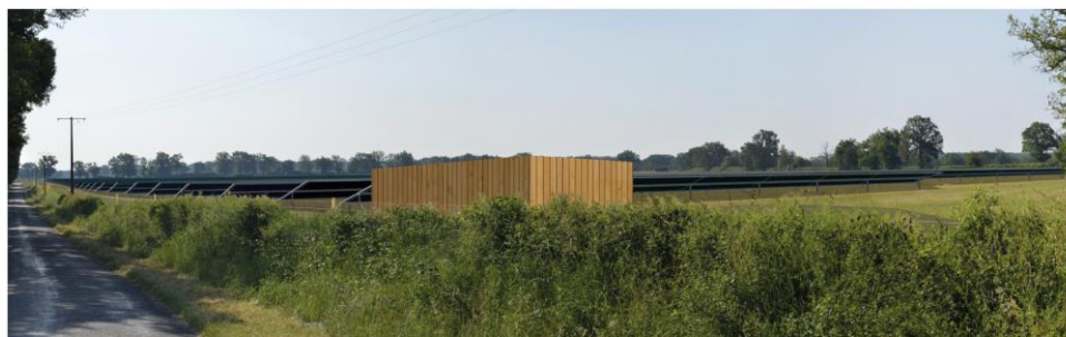
Malgré la présence de la haie bocagère basse (1 à 1.5m de haut environ), le projet se révèle sur l'ensemble du champ visuel. Les postes électriques de transformation en arrière de la haie bordent la RD 32. Il font l'objet d'un traitement de façade en bois qui grisera avec le temps. On peut apercevoir quelques émergences du poste HTB en arrière plan.
