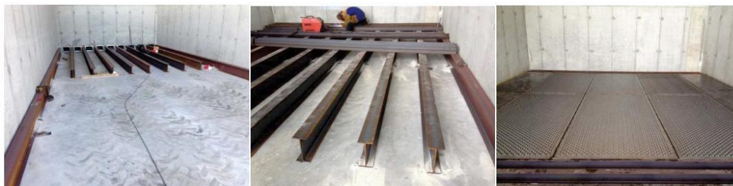
Figure 19: Pose de la structure IP sous les tôles perforées
