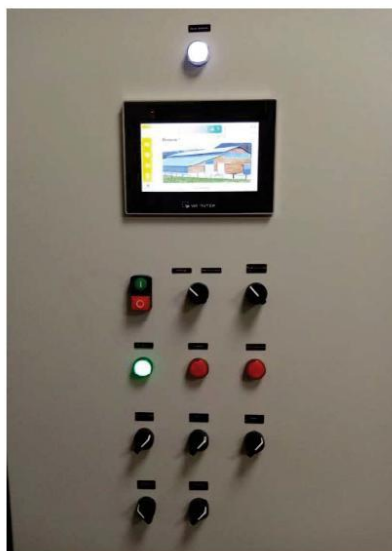
Figure 14: Exemple de façade avec supervision
