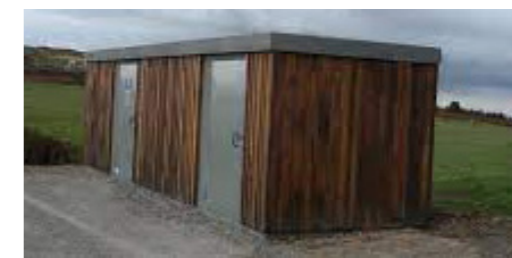
Bardage bois sur les postes électriques
