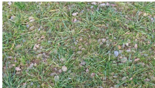
La proportion de terre végétale et de grave est à ajuster en fonction de la portance du sous-sol.
