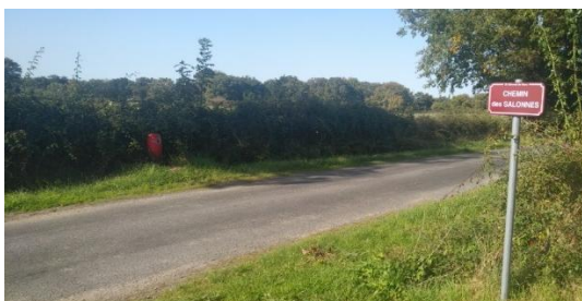
Figure 45 : Borne incendie sur le chemin des Salonnes
