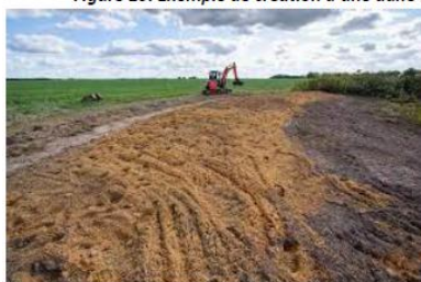
Exemple de création d'une dune de ponte en phase chantier
