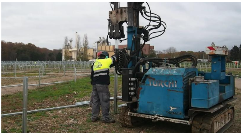
Figure 39 : Exemple d'ancrage (source : SOG Solar)
