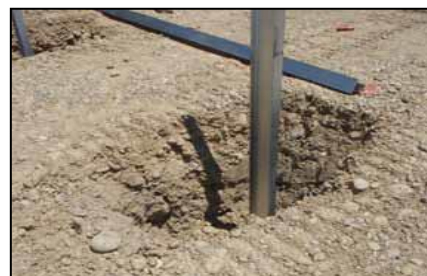
Figure 5 - ancrage par pieux battus
