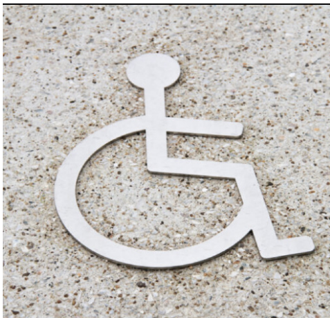
Marquage en fonte possible des places PMR Source: Catalogie «Avenir Voirie»
