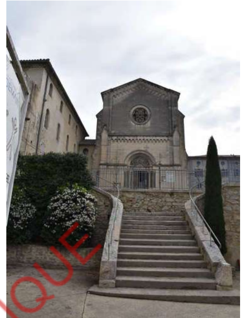
Photo repérage 1er trimestre 2021
