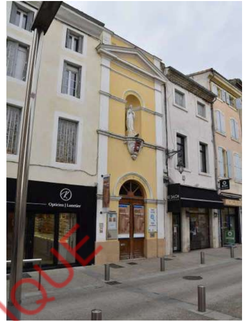
Photo repérage 1er trimestre 2021
