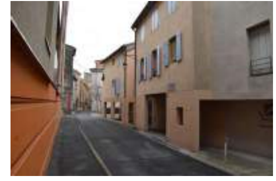
Photo rue de la Cuiraterie (à droite l'opération des années 1990 et à gauche l'opération récente)
