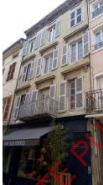
Protections solaires par volets persiennés
