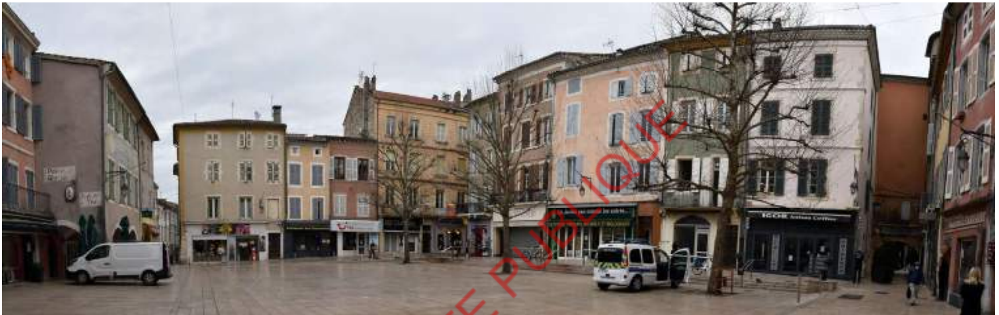
Vue des façades de la place du Marché
