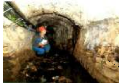
Canal des Moulins aujourd'hui voûtés
