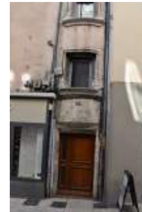
Tour d'escalier, 59 Rue Pierre Julien
