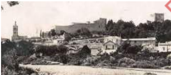
Quartier d'Aleyrac le long du Roubion
