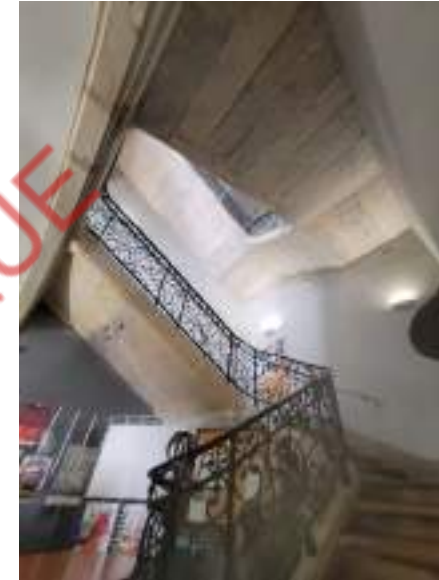
Escalier d'honneur à double volée et sa rampe en ferronnerie
