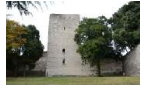
Tour de Narbonne - Eléments protégés : tour et mur de fortification la reliant au château Classement par arrêté du 5 octobre 1938
