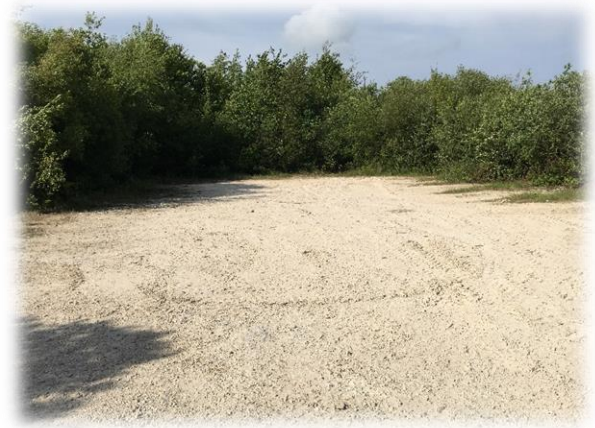
Photo 6. Plateforme industrielle – R. HENRY
