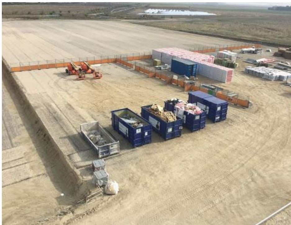
Figure 98 : Bennes de tri des déchets sur un chantier
