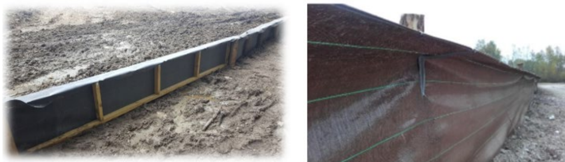
Barrière anti-intrusion avec système anti-retour de type équerre (©Ecosphère)
