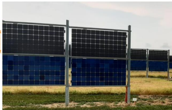
Figure 20 : Schéma de principe d'un panneau photovoltaïque bifacial (Source : TotalEnergies)
