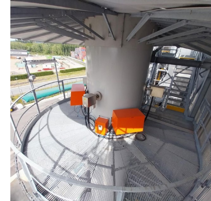
Prélèvement des fumées en cheminée
