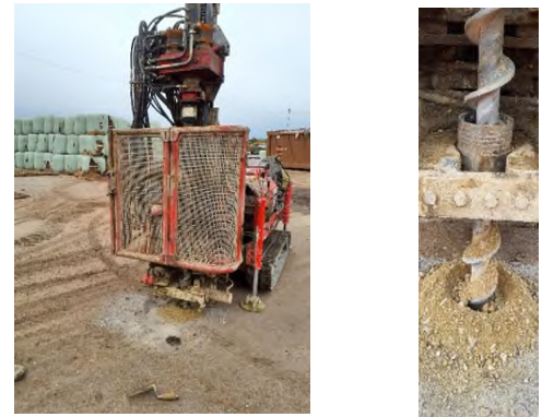
photographie du sondage
