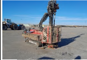
photographie du sondage
