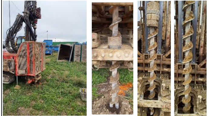
photographie du sondage
