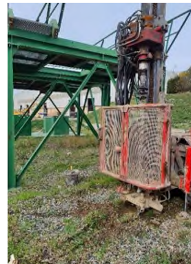
photographie du sondage
