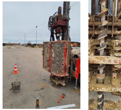
photographie du sondage
