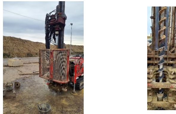
photographie du sondage
