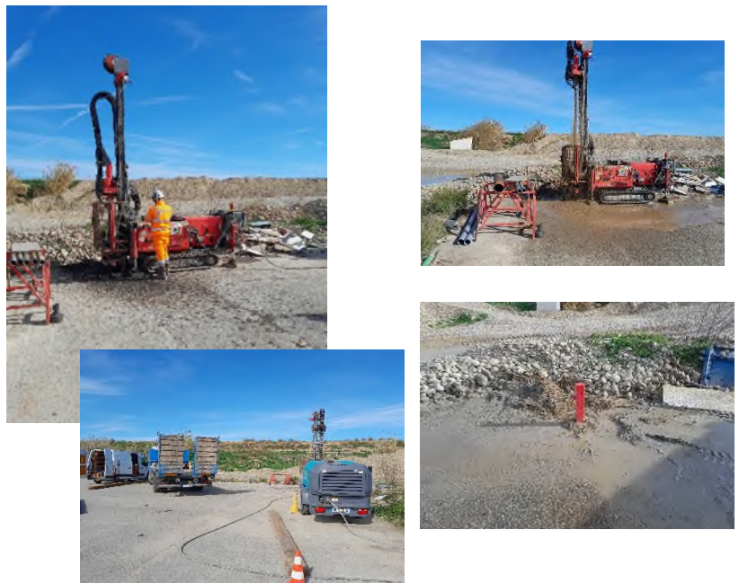
photographie du sondage
