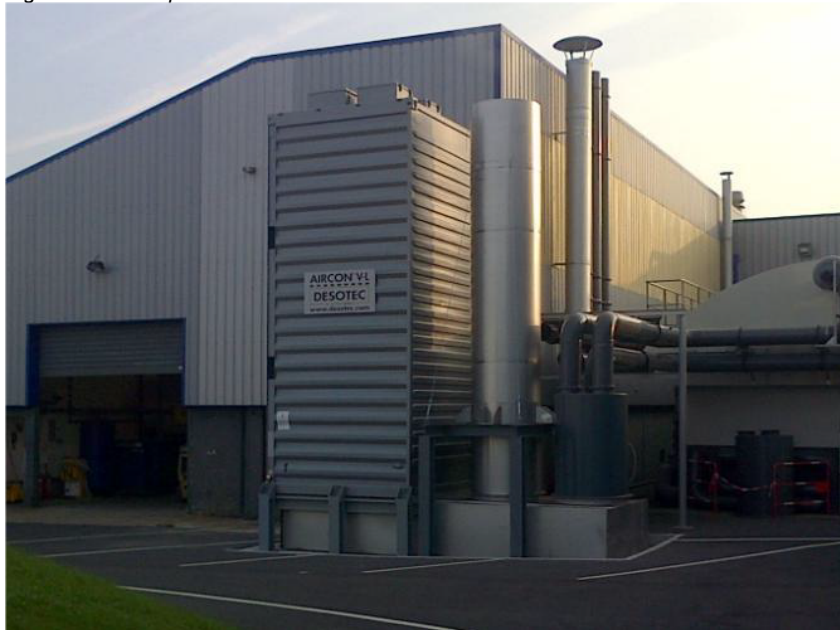
Figure 15 : Exemple de filtre à air utilisable sur l'unité biodéchets
