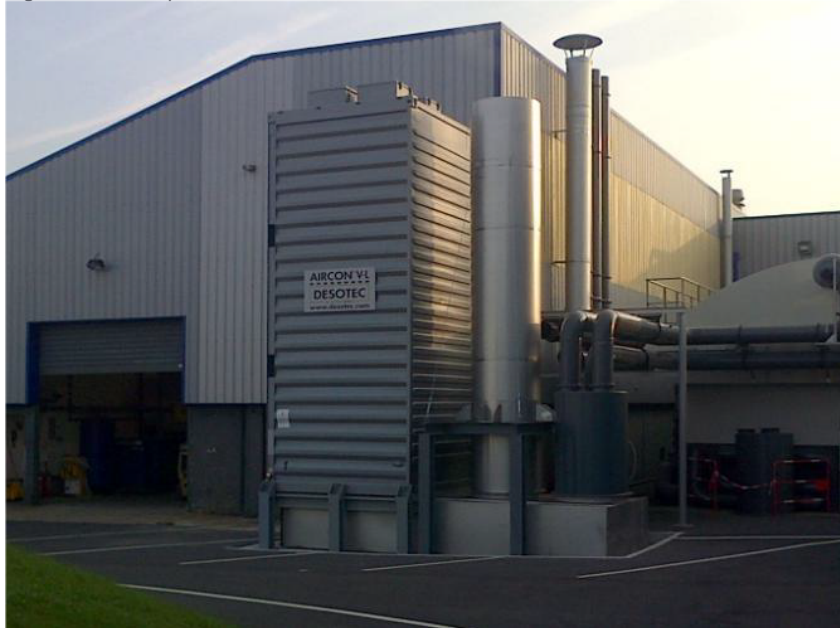
Figure 16 : Exemple de filtre à air utilisable sur l'unité biodéchets
