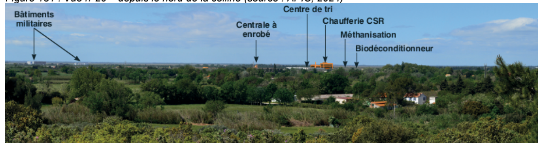
Figure 131 : Vue n°20 – depuis le nord de la colline (source : APIC, 2024)
