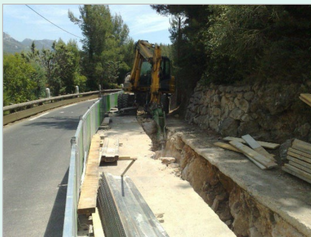
Chantier de pose de liaison souterraine
