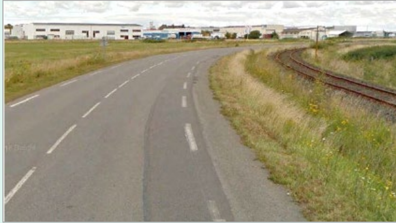
Réfection d'une chaussée après travaux
