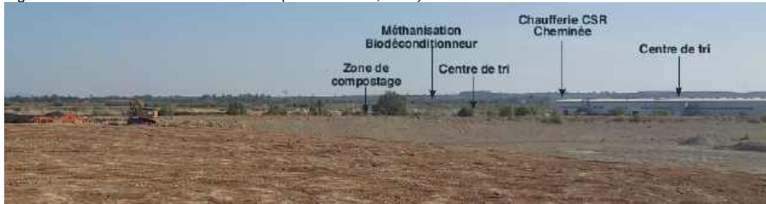
Figure 115 : Vue n°6 - sur le centre de tri (source : APIC, 2024)
