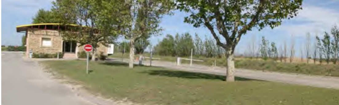
Figure 90 : Bâtiment d'accueil et barrière d'accès à l'EcoPôle du Tubé (source : Suez, 2018)
