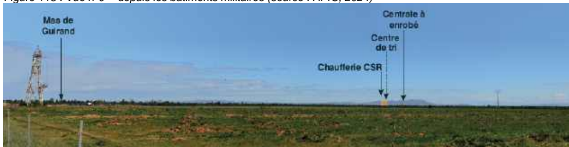
Figure 118 : Vue n°9 - depuis les bâtiments militaires (source : APIC, 2024)
