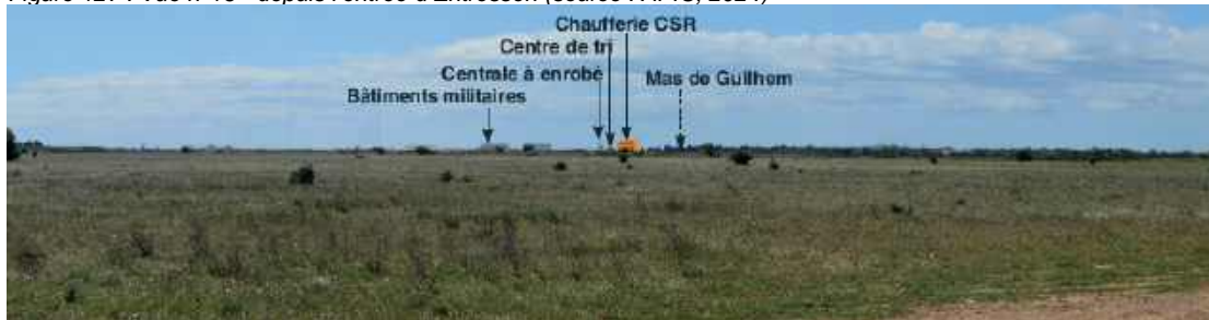
Figure 127 : Vue n°16 - depuis l'entrée d'Entressen (source : APIC, 2024)
