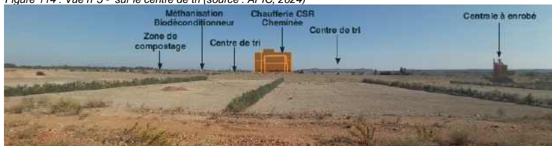
Figure 114 : Vue n°5 - sur le centre de tri (source : APIC, 2024)
