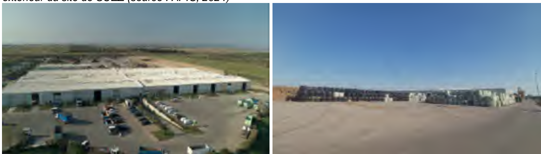
Figure 107 : De gauche à droite puis de haut en bas : Centre de tri ; Zone de stockage ; Bassin de rétention ; Chemin extérieur du site de SUEZ (source : APIC, 2024)
