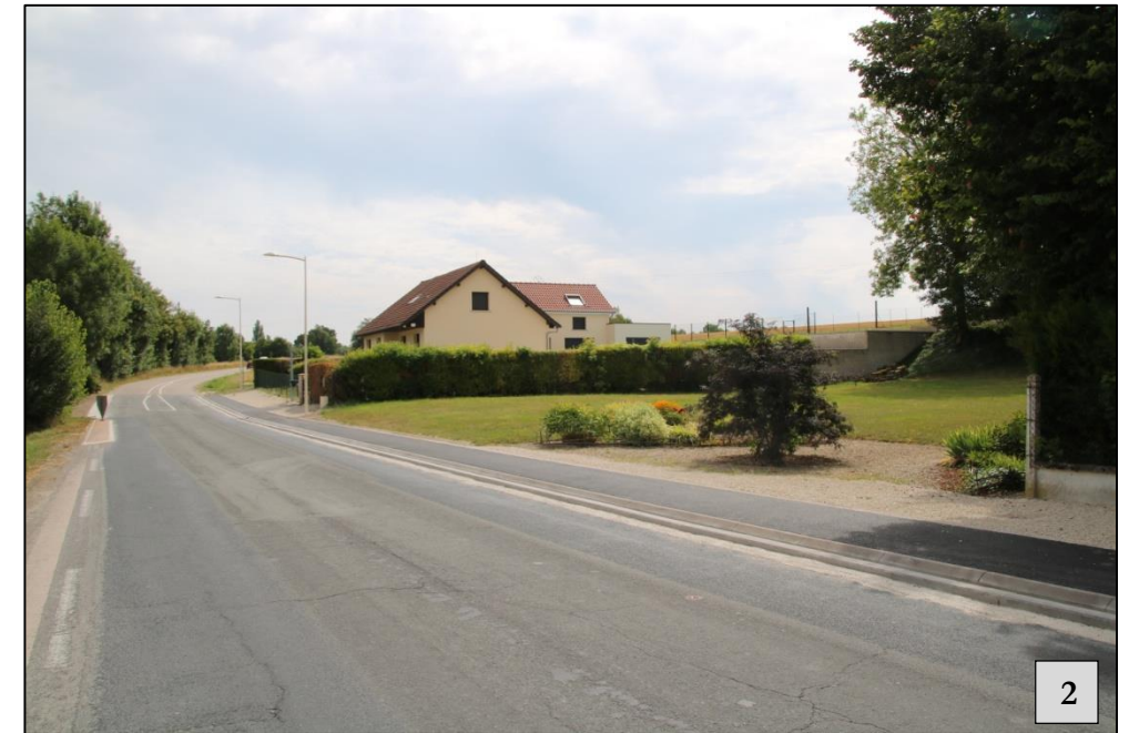
Photo 79 : Vue depuis la D1, sortie Est de Coupéville (Source : BE JC)
