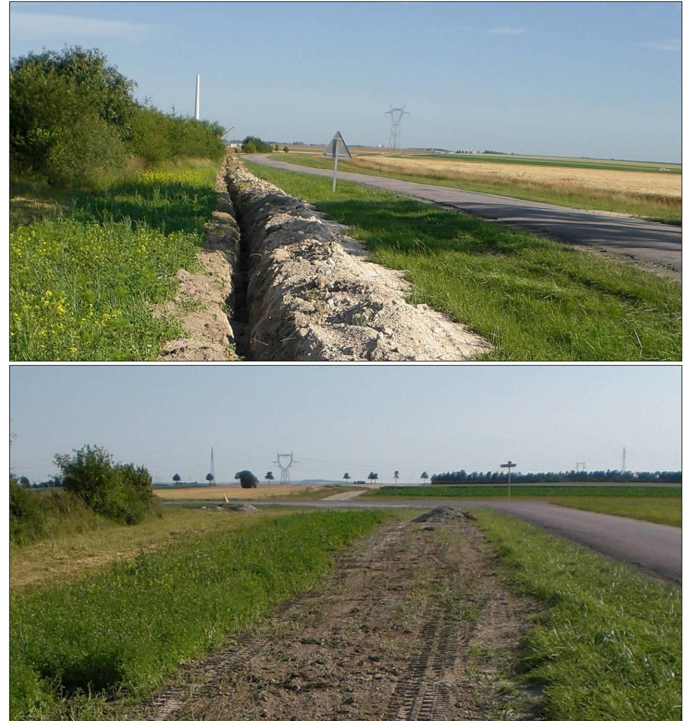
Photo 124 : Rebouchage de tranchée après passage des câbles électriques (Source : BE JC)
