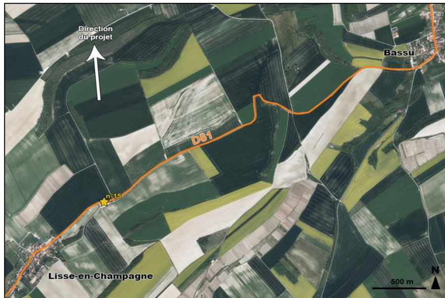
Figure 41 : Vue aérienne de la D81 reliant Lisse-en-Champagne et Bassu (Source : BE JC)
