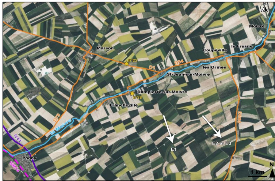
Figure 35 : Vue aérienne des villages de la vallée de la Moivre (Source : BE JC)
