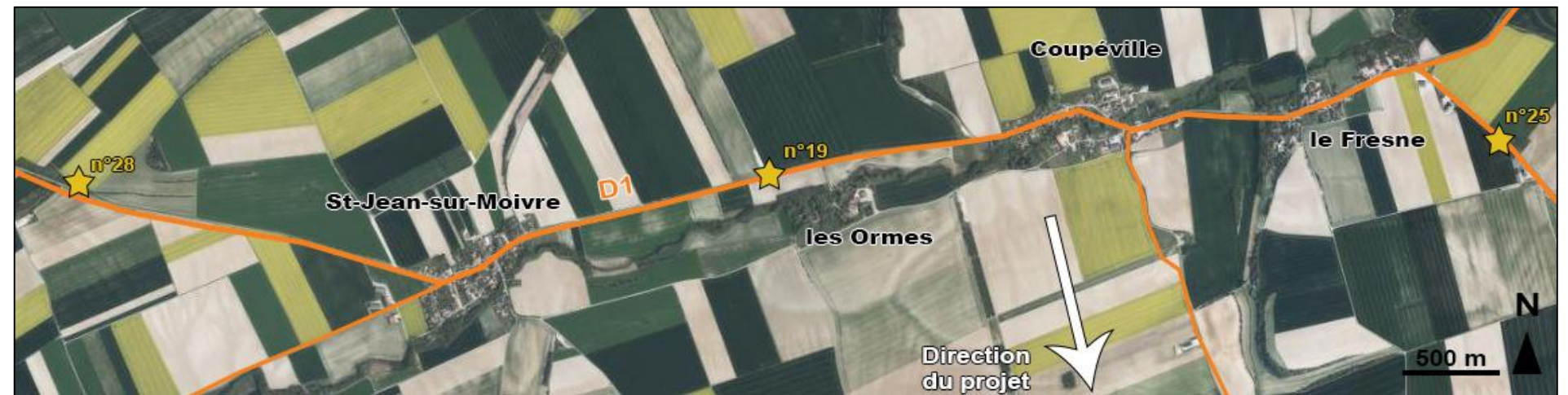
Figure 38 : Vue aérienne de la D1 entre Saint-Jean-sur-Moivre et le Fresne (Source : BE JC)
