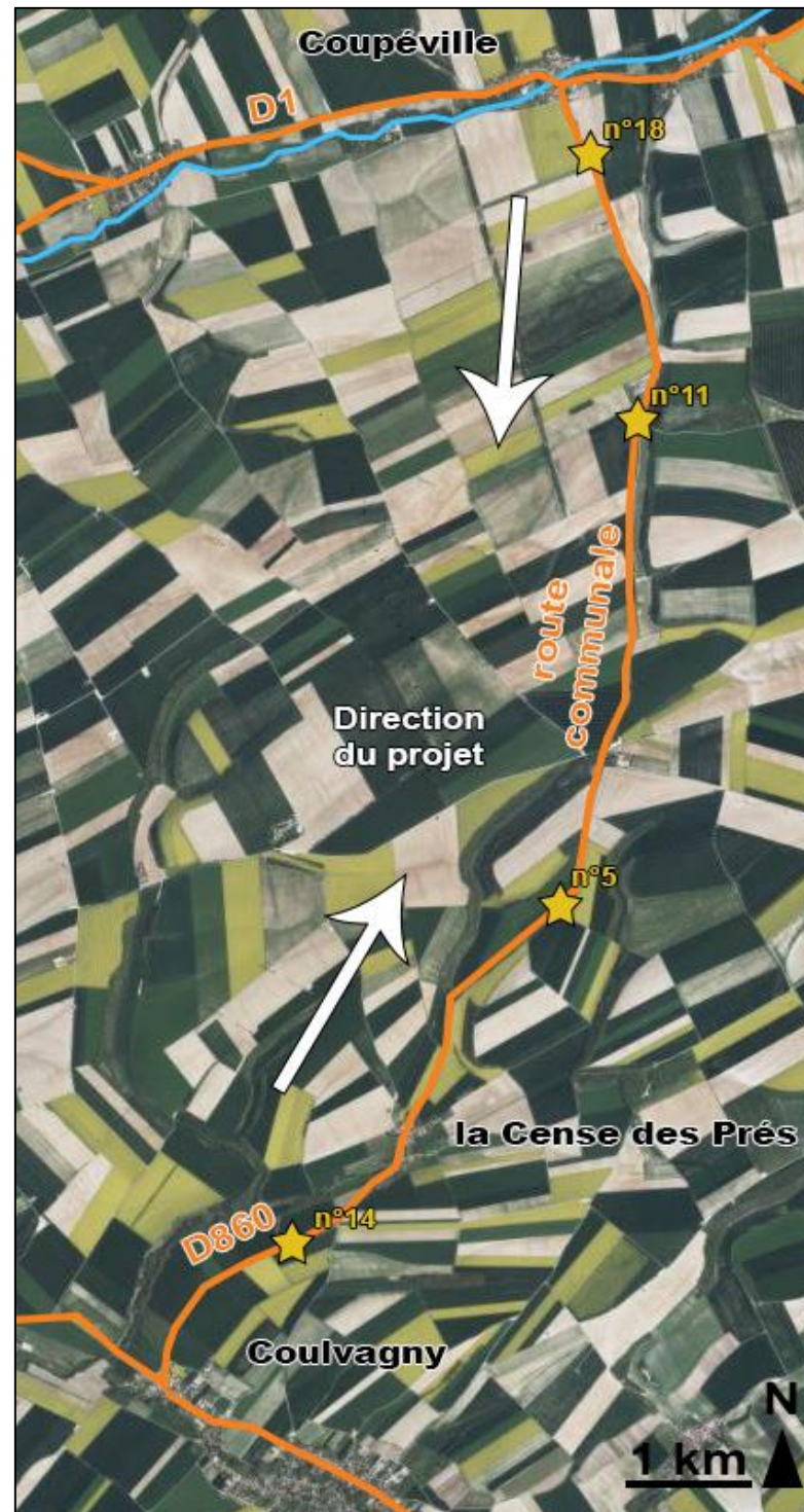
Figure 36 : Vue aérienne de la D860 et de la route communale de La Cense des Prés reliant Coulvagny et Coupéville (Source : BE JC)
