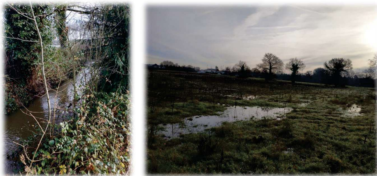
Vue de l'Orson et d'une parcelle limitrophe partiellement inondée pendant les crues de janvier 2025 – Source : DMEAU, 2025
