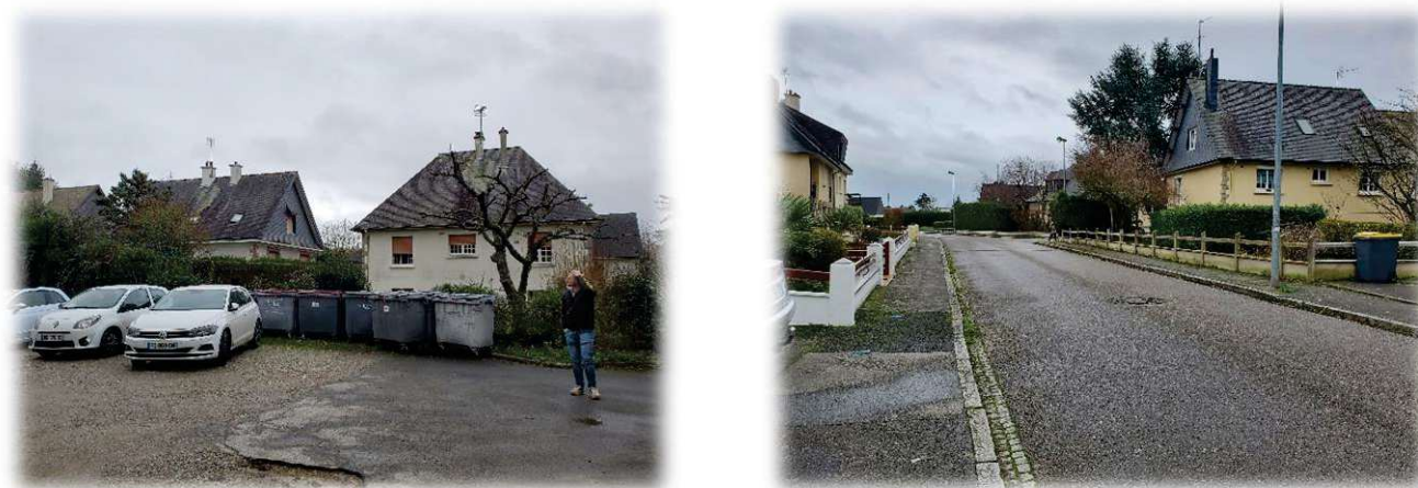
Vues de maisons individuelles typiques des années 70, et du cœur d'îlot accessible depuis la voie publique – Crédits photographiques : DMEAU décembre 2022
