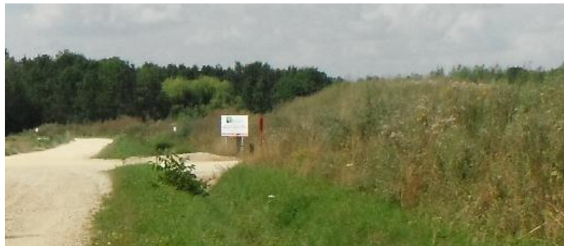
Merlons ceinturant le site de la carrière et de l'installation de traitement des Ets Blandin sur la commune de Luxémont-Villotte
