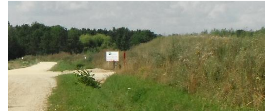
Exemple de merlon en périphérie d'un site des Ets Blandin SAS
