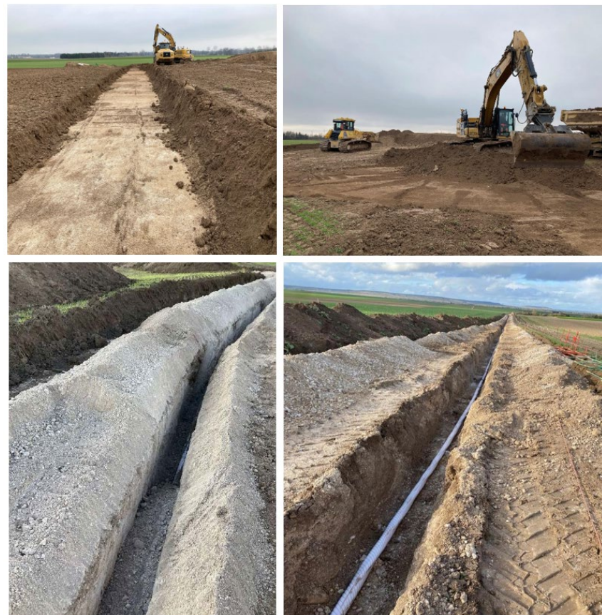
Figure 5: Enfouissement des câbles
