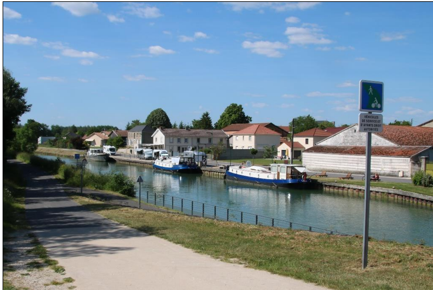
Photo 42 : Canal Latéral de la Marne, et le port de plaisance de Pogany (Source : BE JC)
