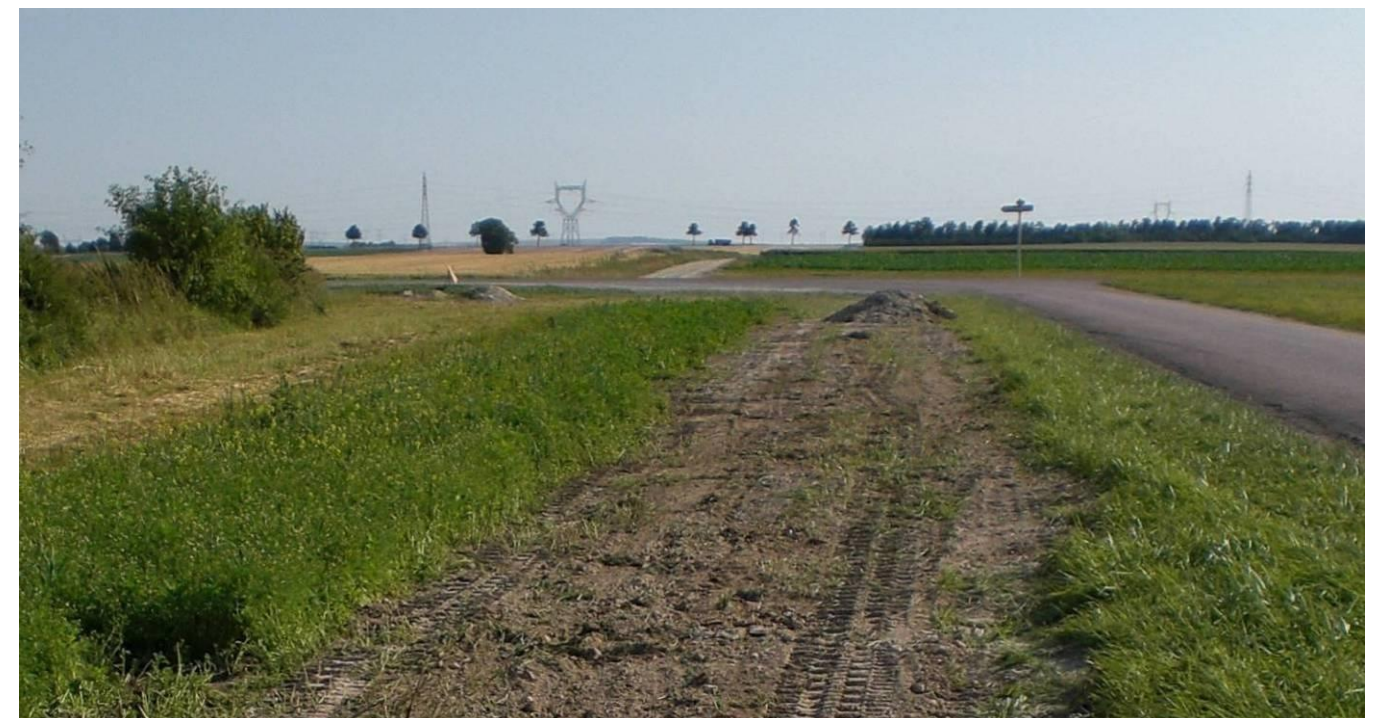
Photo 124 : Rebouchage de tranchée après passage des câbles électriques (Source : BE JC)
