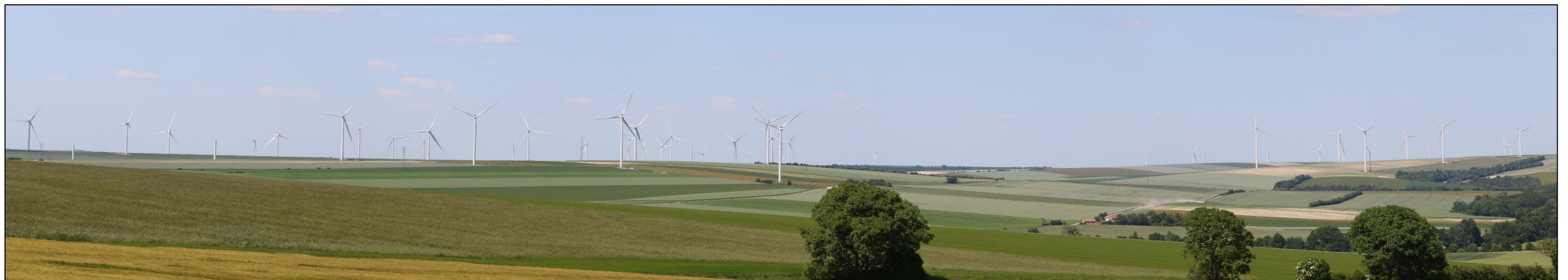
Photo 44 : Vue depuis le route N44 en direction de la ZIP, sur la Champagne Centrale, ses grands champs ouverts et sa composante éolienne (Source : BE JC)
