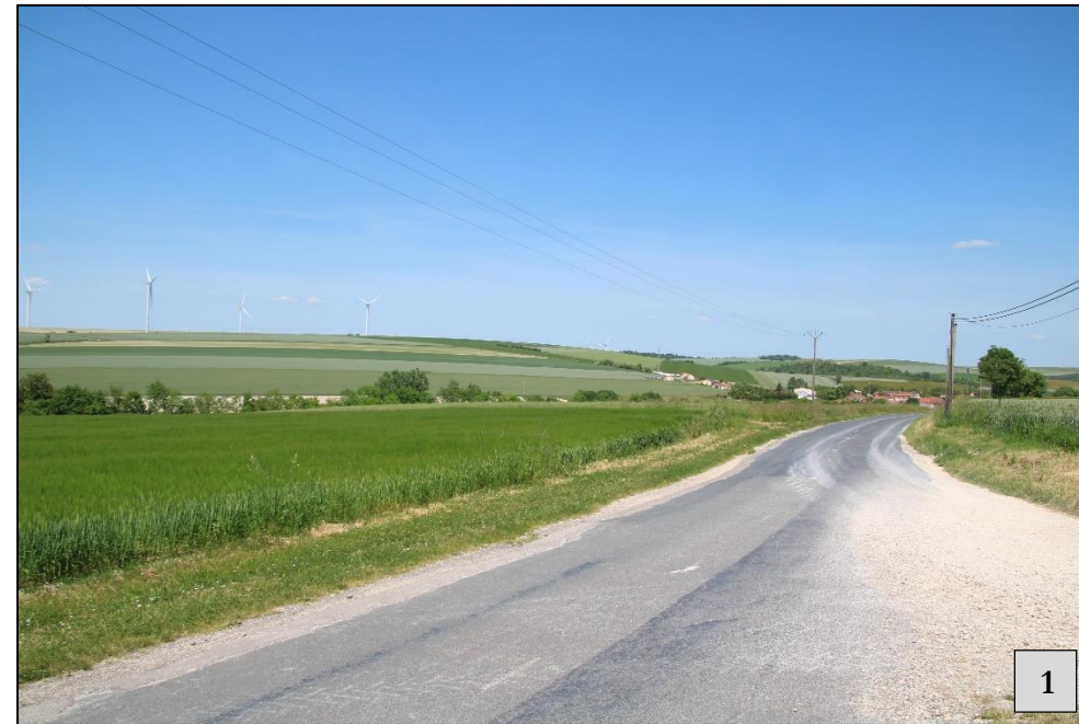
Photo 79 : Vue en direction de la ZIP, à proximité de la Cense des Prés, depuis la route D860 (Source : BE JC)
