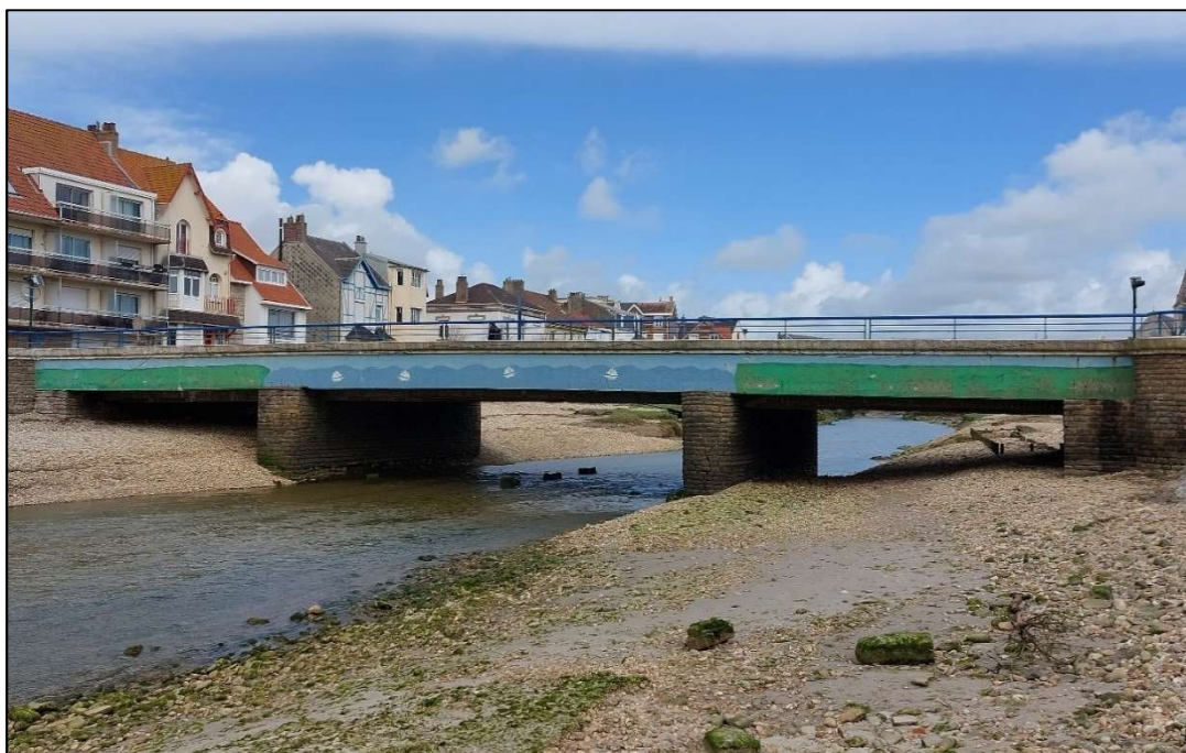
Photographie du Pont Napoléon depuis les berges du Wimereux (avril 2023)
