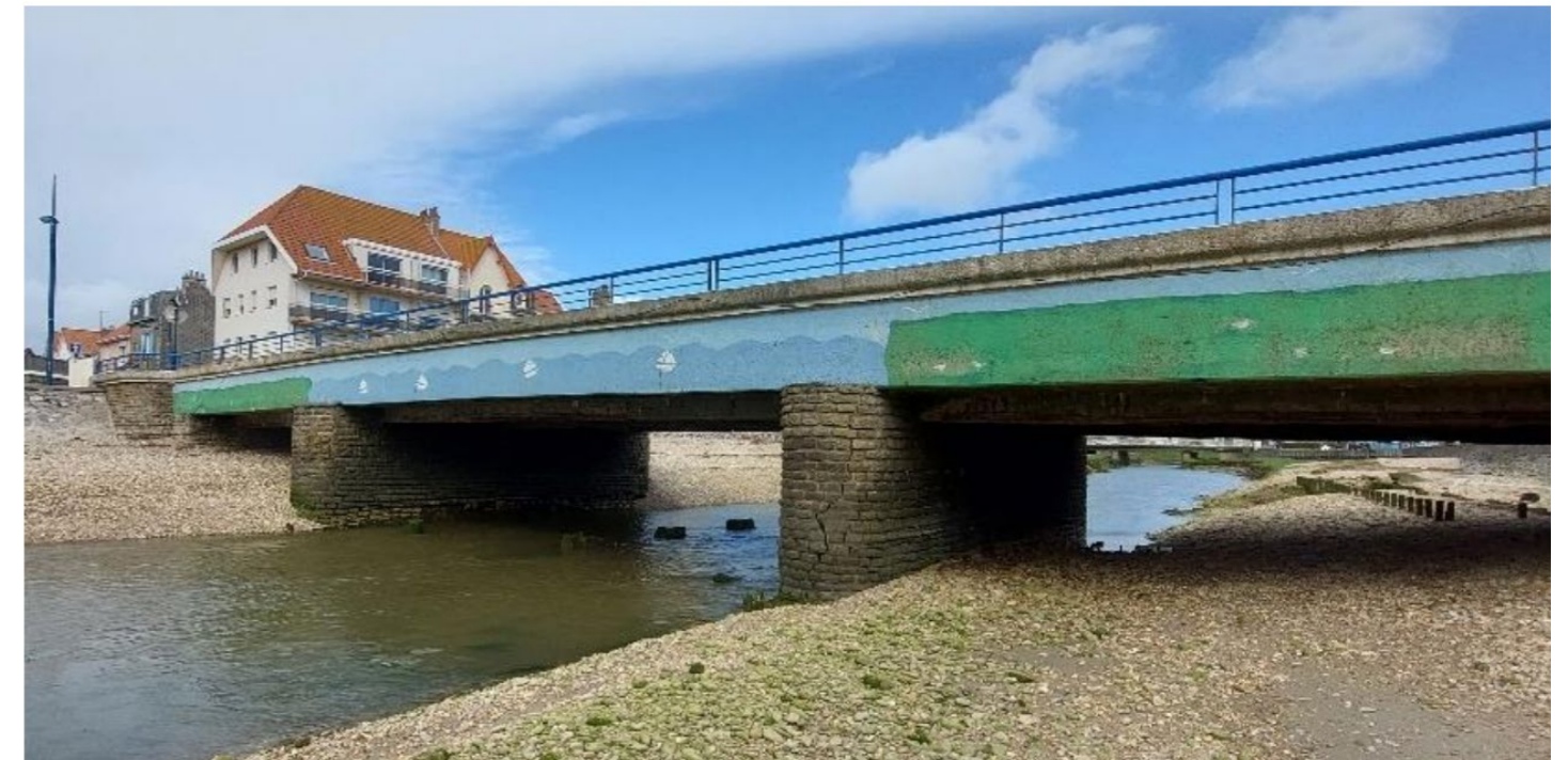
Figure 5 : Photographies du pont Napoléon existant. Source : Notice architecturale, AIA.
