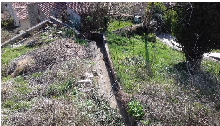
Figure 12 : Canal en aval du chemin de randonnée
