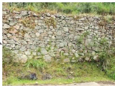
Exemple de murs de soutènement
