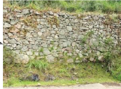
Exemple de murs de soutènement
