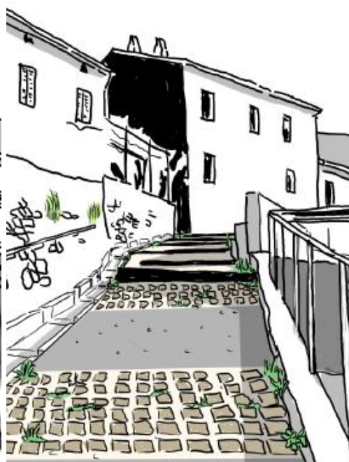
Alternance bande bitumée et pavage Caniveau latéral
