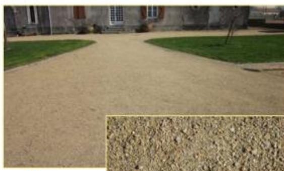
Stabilisé mécaniquement « CHAPE »
