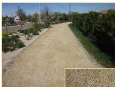
Stabilisé mécaniquement « STABILISÉ CALCAIRE »
