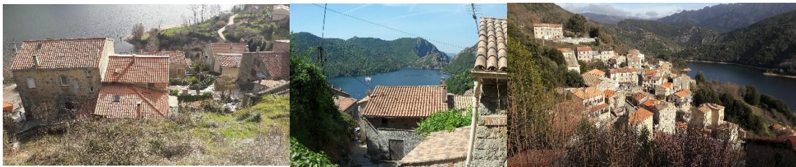
Les toitures dans les vues d'intérêt
