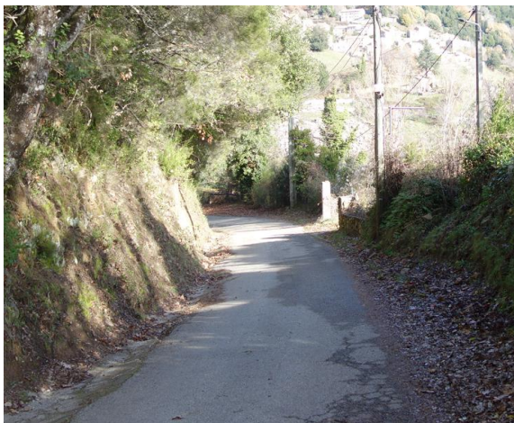
Route d'accès au lac à élargir grâce à l'ER.
