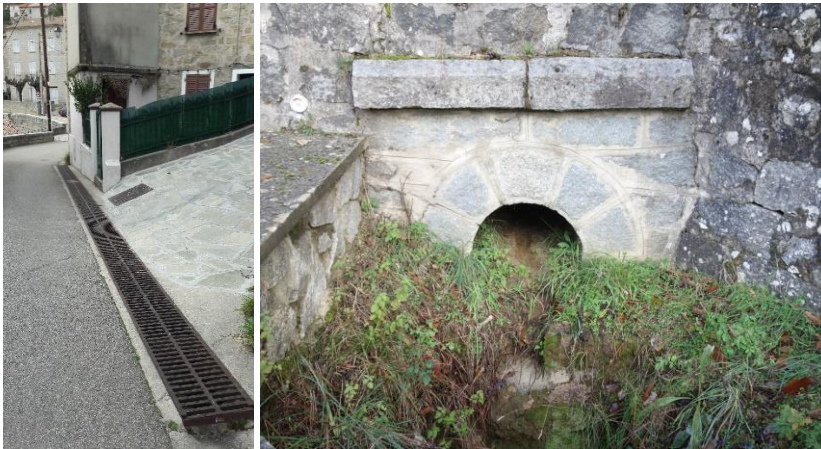
Des ouvrages anciens et contemporains qui sont conservés et consolidés
