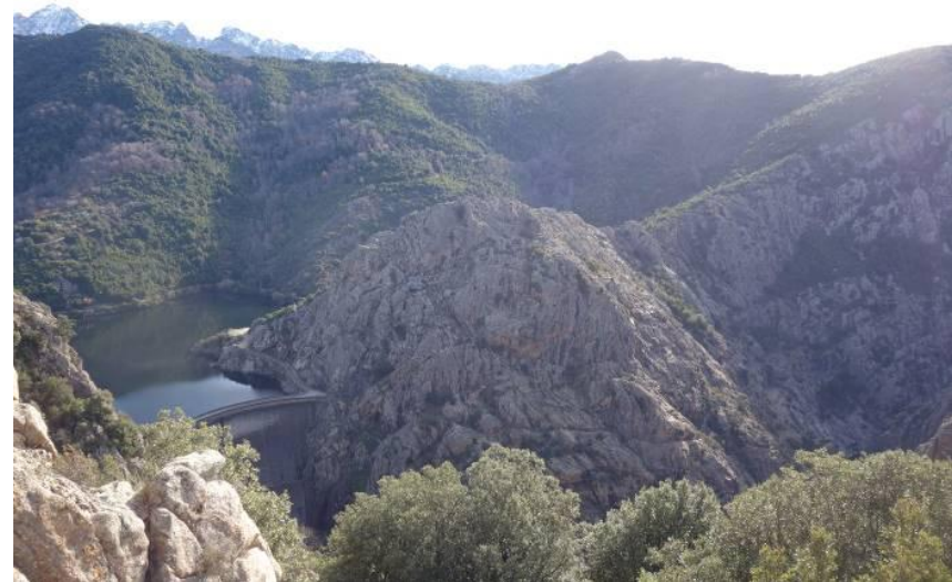
Le barrage de Tolla : ressource d'Ajaccio et ses environs
