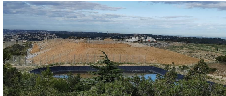
Casier de l'ISDND en cours d'exploitation (GEOENVIRONNEMENT, 27/09/2024)
