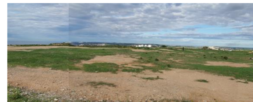
Ancien casier déjà exploité du sous-secteur 3a (GEOENVIRONNEMENT, 27/09/2024)
