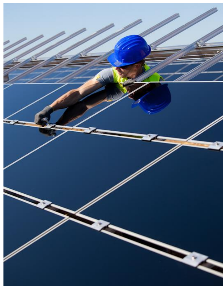
Remplacement de module (crédit photo EDF Renewables)
