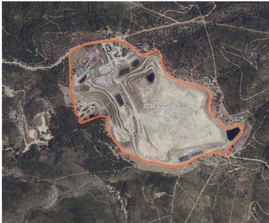
Figure 2 : Vue du site sur Photographie aérienne (source : EDF R)
