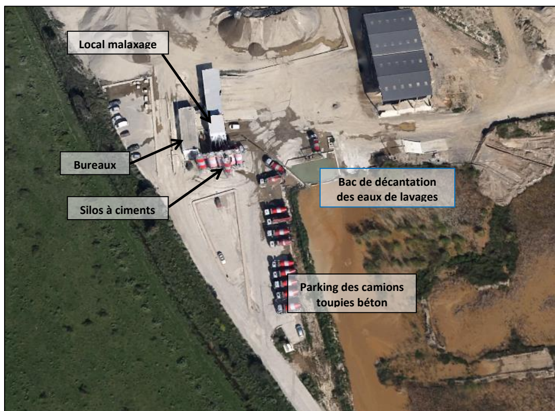
Figure 10. Vue aérienne de l'installation de centrale à béton (Source : Google Earth 2013)
