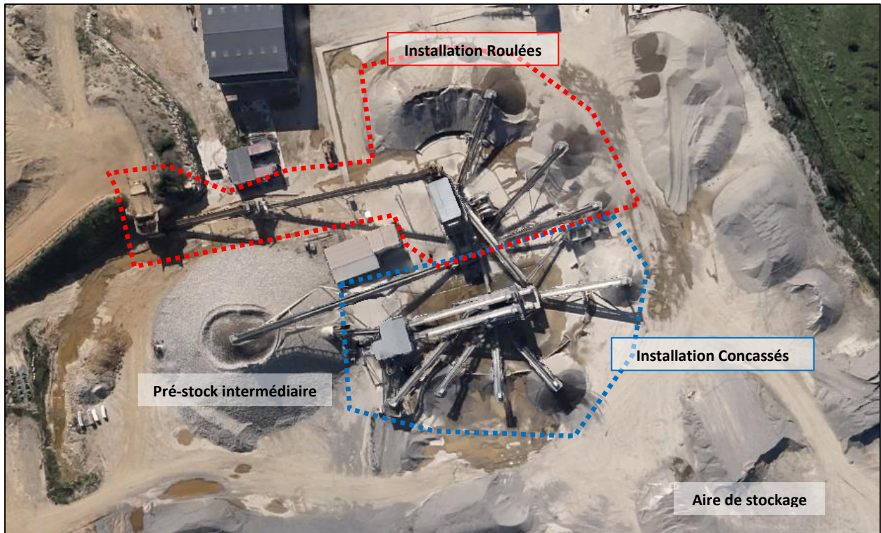
Figure 9. Vue aérienne de l'installation de concassage et de criblage (Source : Google Earth 2013)
