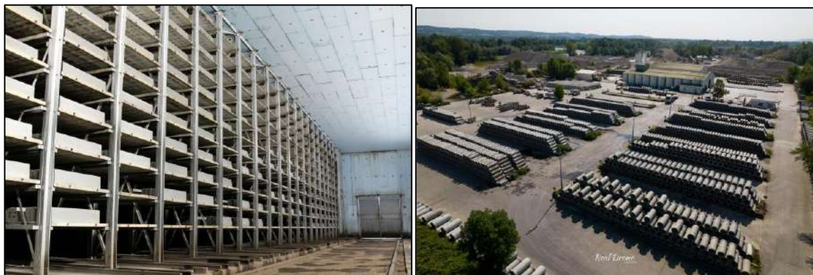
Figure 4 : unités de préfabrication du groupe Daniel
