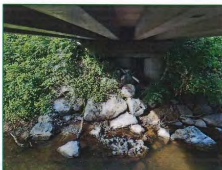
Figure 33 : Vue de la culée rive gauche
