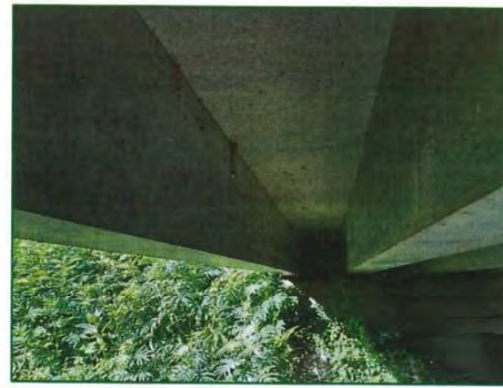
Figure 36 : Vue de générale des poutres et de l'intrados
