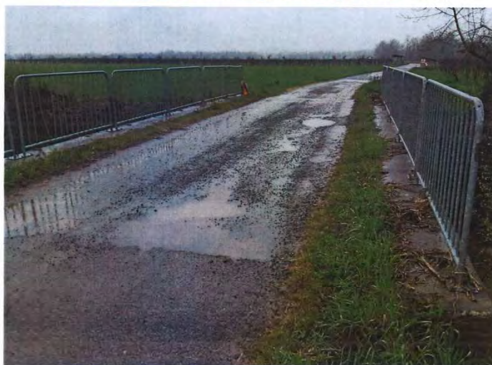
Figure 20 : Photo prise lors de la visite de reconnaissance
