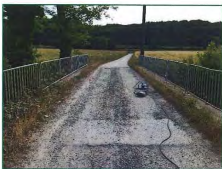
Figure 31 : Vue générale de l'extrados
