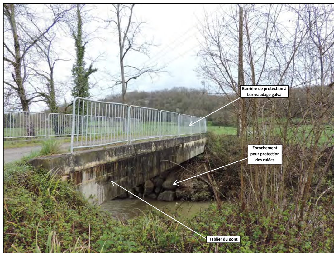
Figure 21 : vue zoomée Face amont du pont de Gouat (source : DPL)
