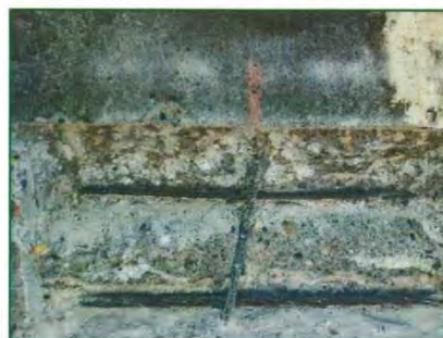
Figure 19 : Relevés au droit de la fenêtre F02
