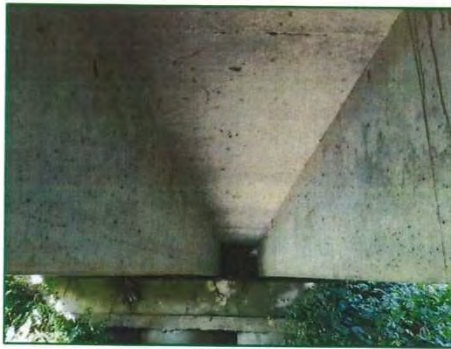
Figure 35 : Vue de générale des poutres et de l'intrados
