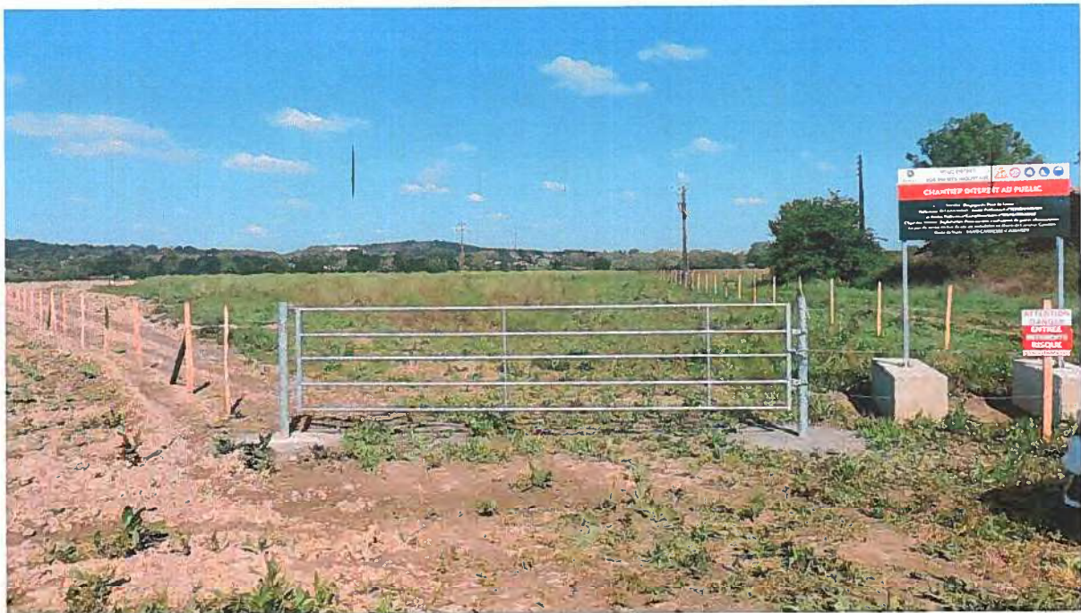
Photographie 15 : Vue du portail d'accès et clôture Nord
