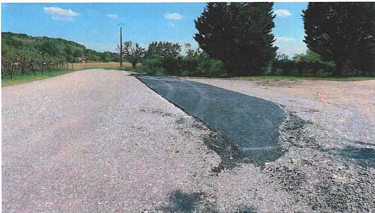
Photographie 11 : Aire de croisement n°2 (chemin de liaison Bergeres-Artigues)
