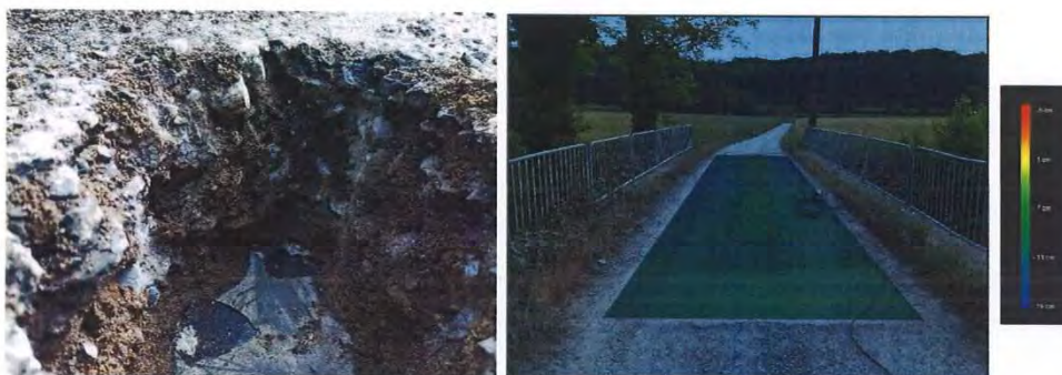
Figure 21 : Sondage et cartographie du revêtement
