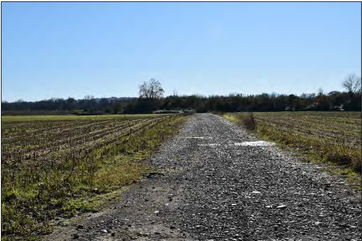
Figure 38 : piste d'accès intérieure au site (ENCEM, décembre 2024)
