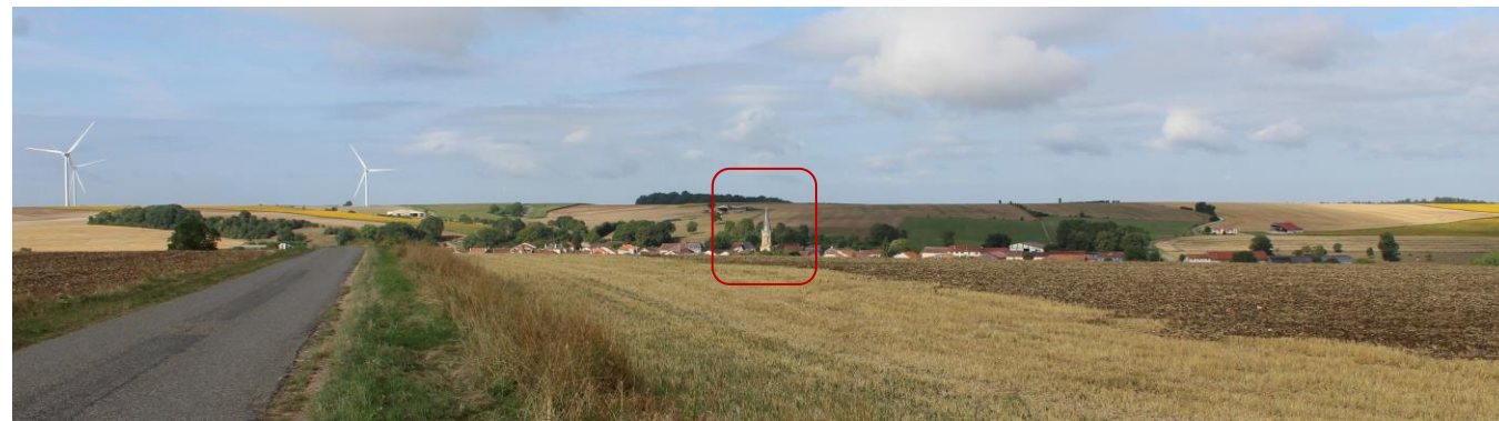
Vue depuis la RD148 en approche de Beausite par l'est
