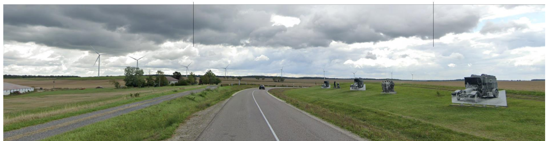
Photo 3. Un développement éolien en relation avec la RD1916, voie historique
