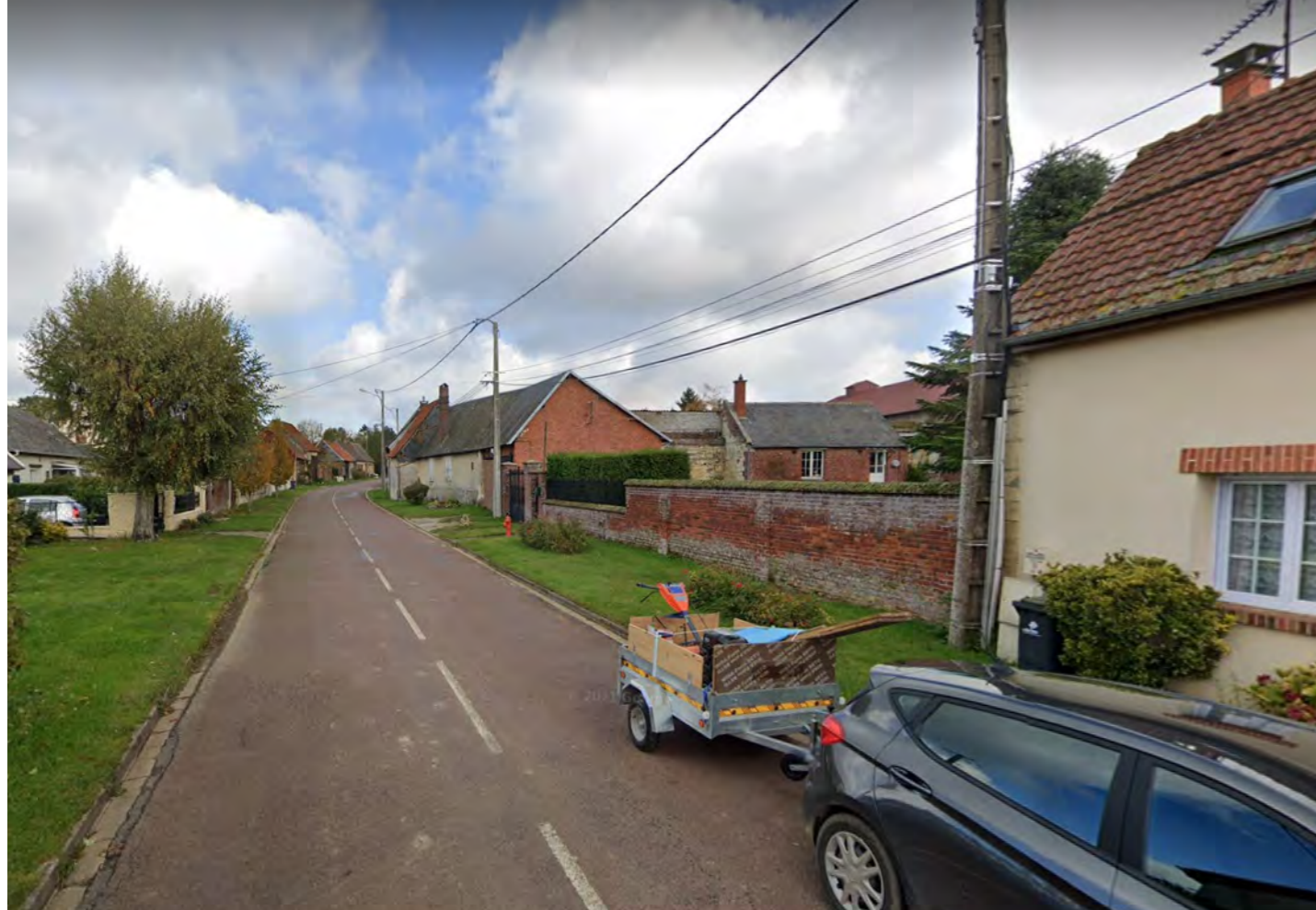
Fig. 155 : La rue d'Ile de France avant la mesure d'enfouissement
