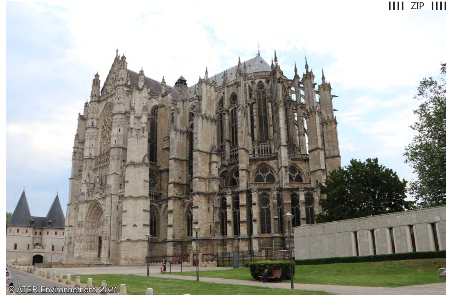
Fig. 79 : Vue sur la cathédrale Saint-Pierre à Beauvais
