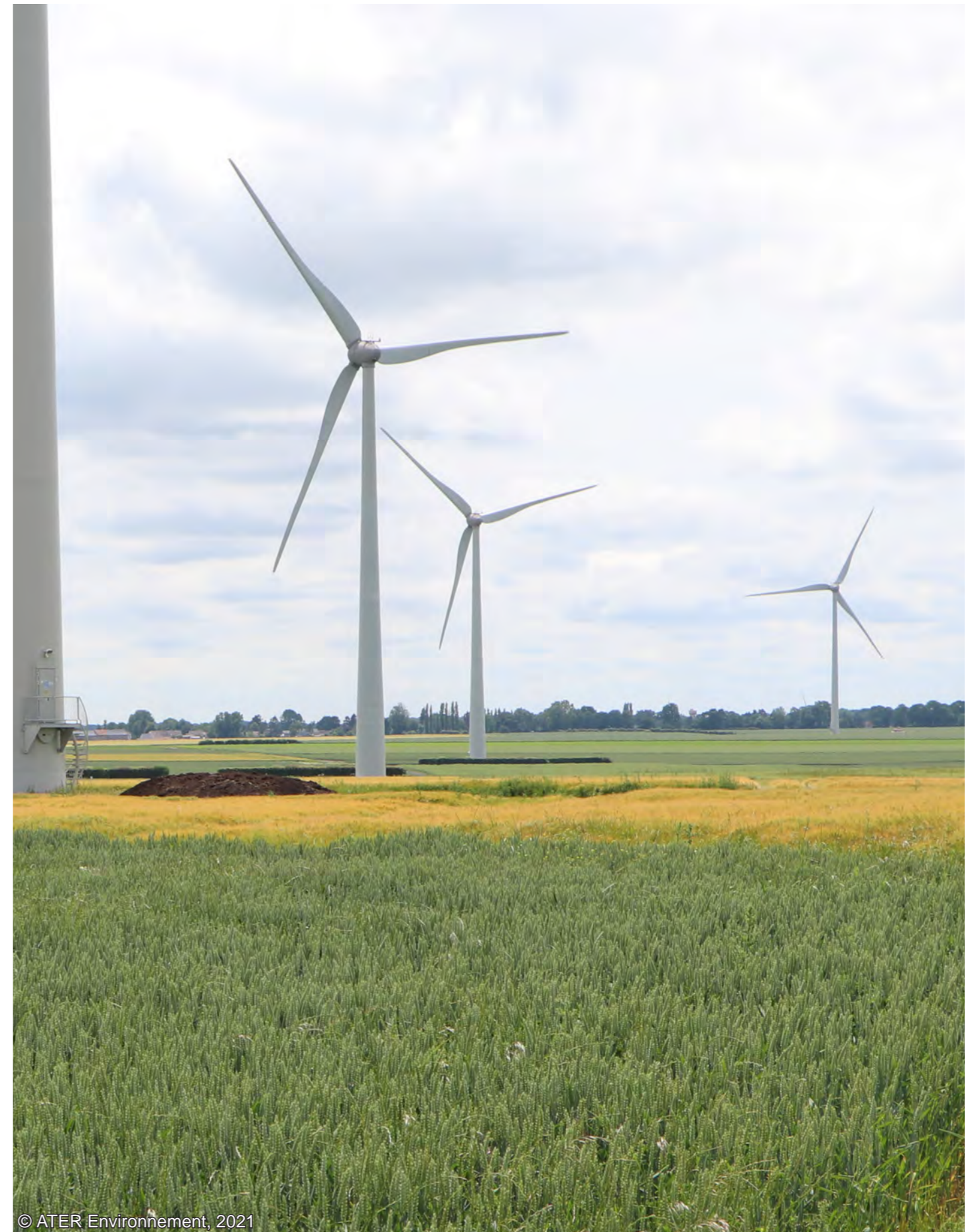
Fig. 24 : Vue sur le parc éolien d'Oursel Maison au croisement de la D930 et de la D11
