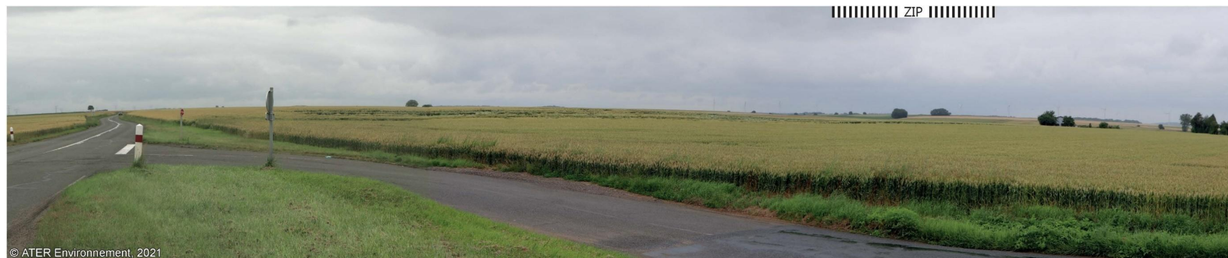
Figure 49 : Vue depuis le croisement entre la N31 et la D34 au nord de Bresles (source : ATER Environnement, 2021)
