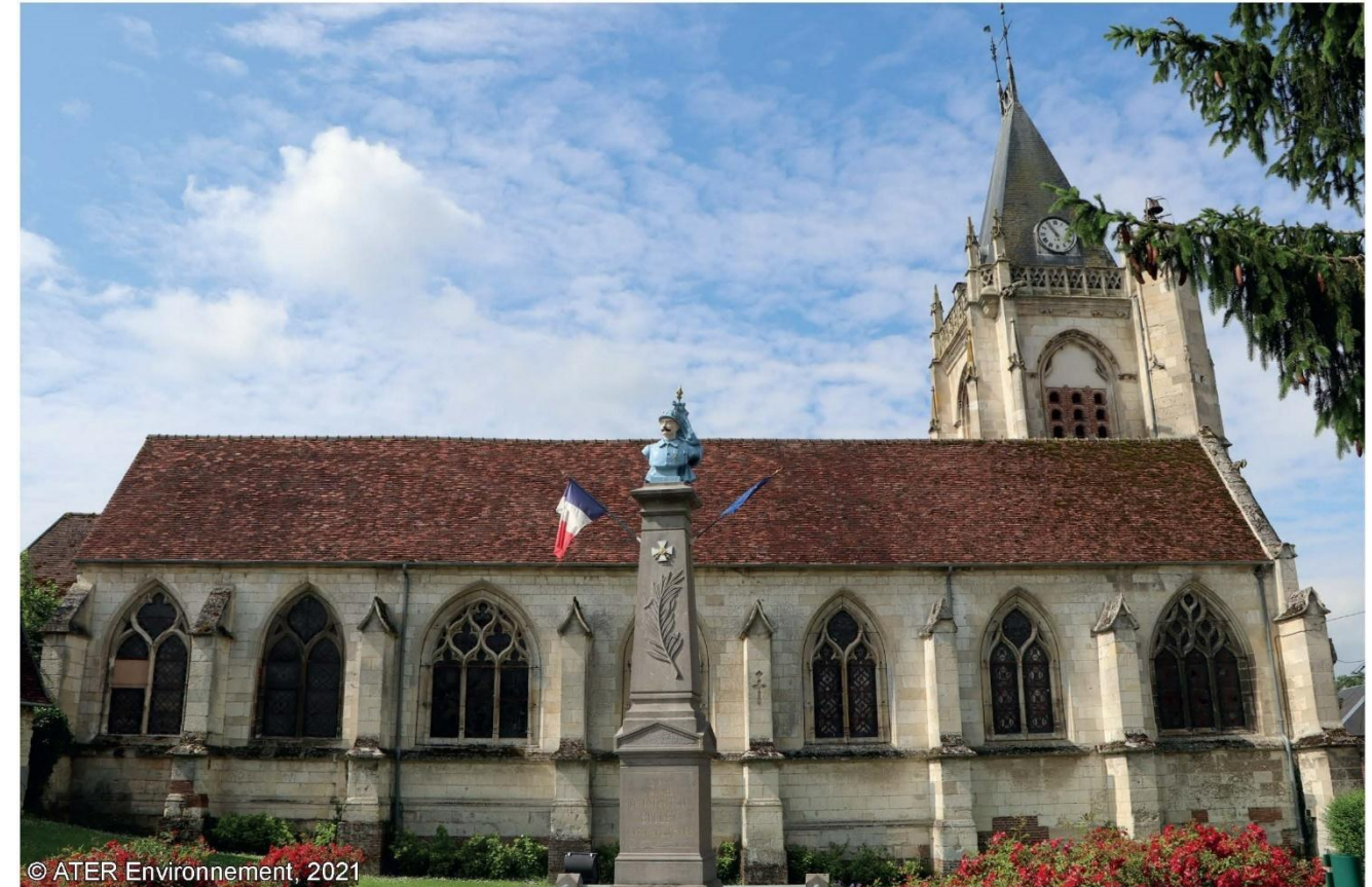
Figure 62 : Vue sur l'église Saint-Martin à Bulles (source : ATER Environnement, 2021)
